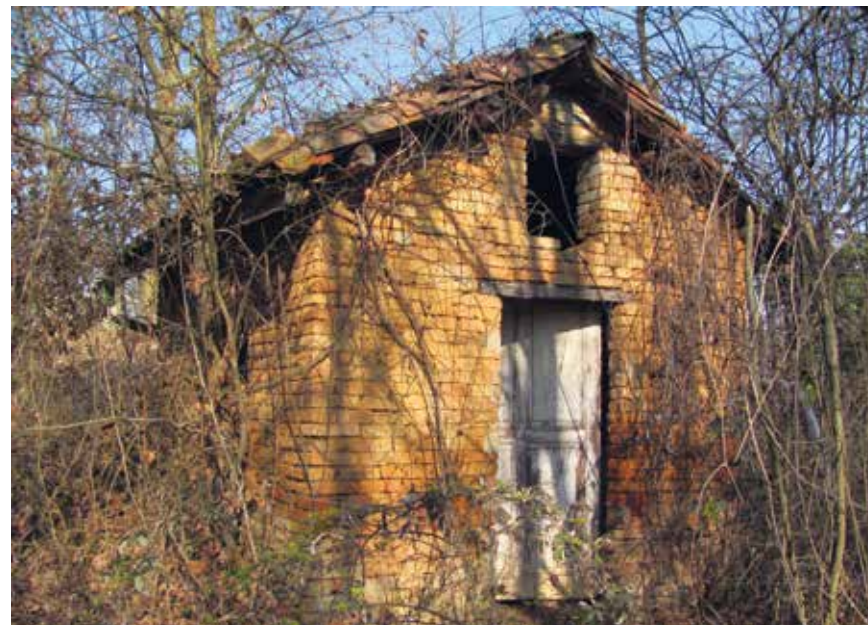
Figura 57: ciabòt nei boschi, con muratura in mattoni, porta di ingresso con architrave ligneo e finestra soprastante
