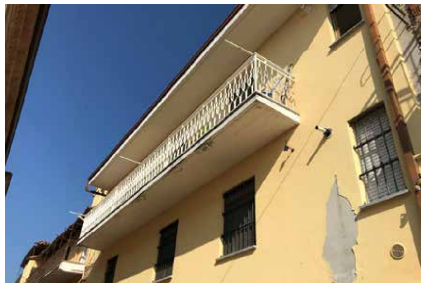
Figura 210: soletta in ca e disegno non compatibile della ringhiera
