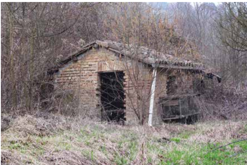
Figura 66: ciabòt in stato di abbandono e boscaglia di invasione
