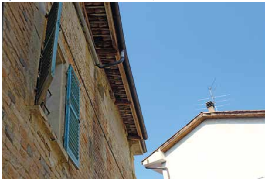
Figura 6: sporto del tetto limitato – Belveglio
