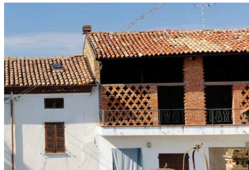
Figura 206: realizzazione di ballatoio esterno al loggiato
