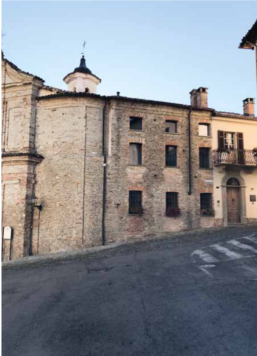
Figura 105: muratura in pietra – Canelli
