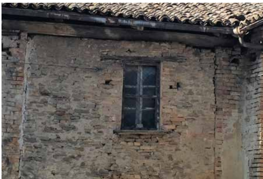
Figura 142: finestra con architrave ligneo - Calosso
