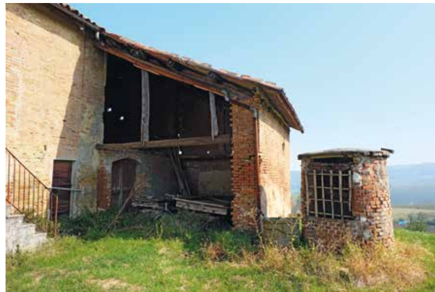
Figura 5: pozzo di forma cilindrica in laterizio e tettuccio piatto - Quaranti
