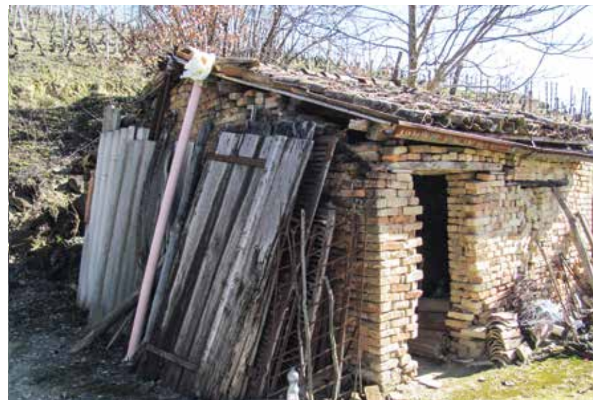
Figura 64: ciabòt in muratura di laterizio con ingresso sul lato della linea di gronda
