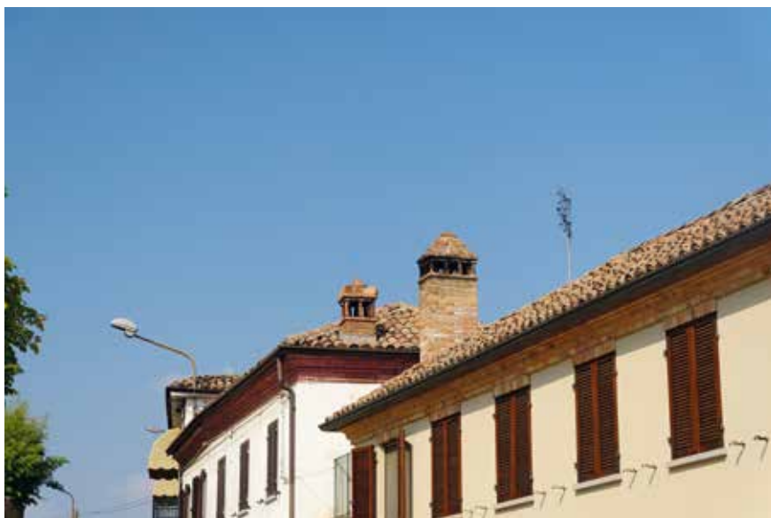
Figura 19: cornice in corsi di mattoni - Coazzolo
