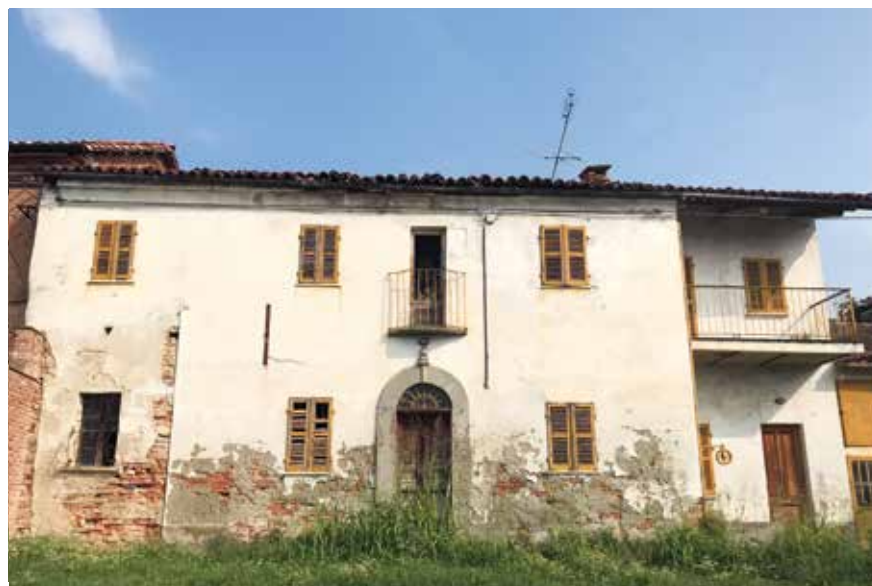
Figura 140: simmetria delle aperture e portoncino di ingresso con portale in pietra – Vigliano d’Asti
