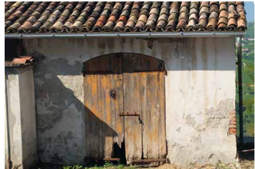
Figura 148: portone di accesso in legno a due battenti ad arco – Calosso
