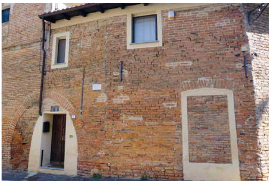
Figura 85: muratura in laterizio con archi e piattabande – Mombaruzzo
