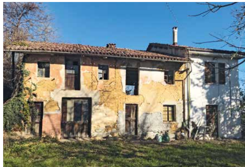
Figura 122: cascina in muratura di terra cruda intonacata – Vinchio
