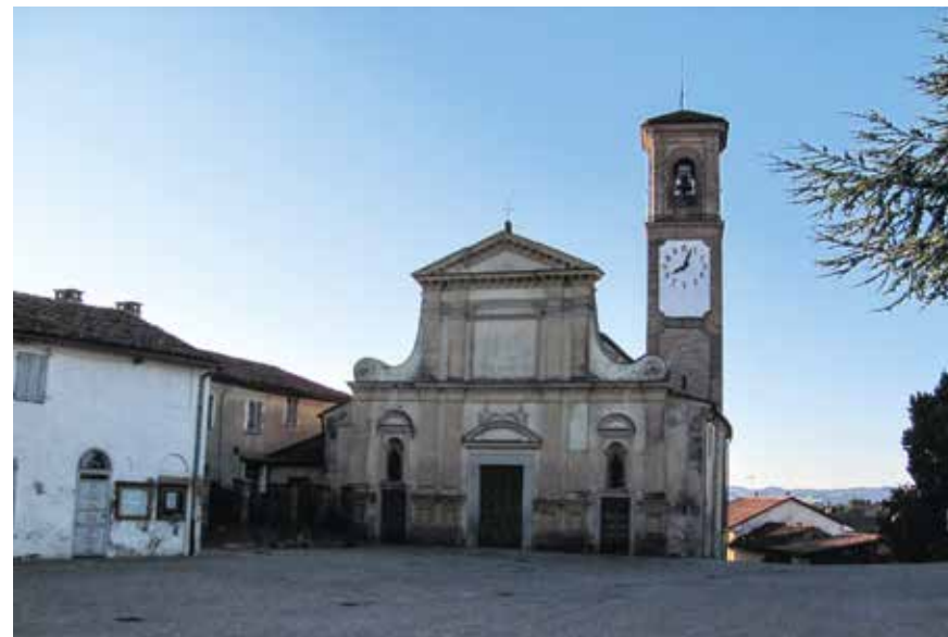
Figura 115: La facciata della chiesa prima dell'intervento
