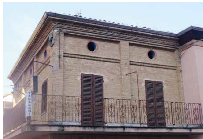
Figura 90: muratura in laterizio - Castelnuovo Calcea
