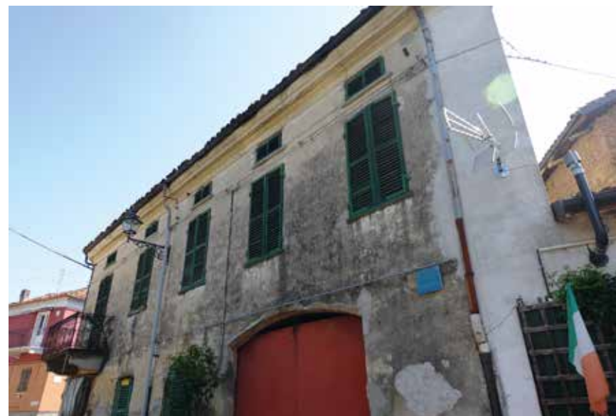
Figura 17: cornicione in intonaco listellato – Montaldo Scarampi
