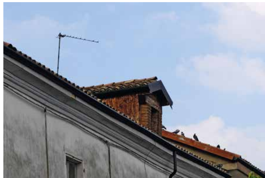
Figura 34: abbaino con struttura in mattoni e tetto a capanna – Isola d'Asti
