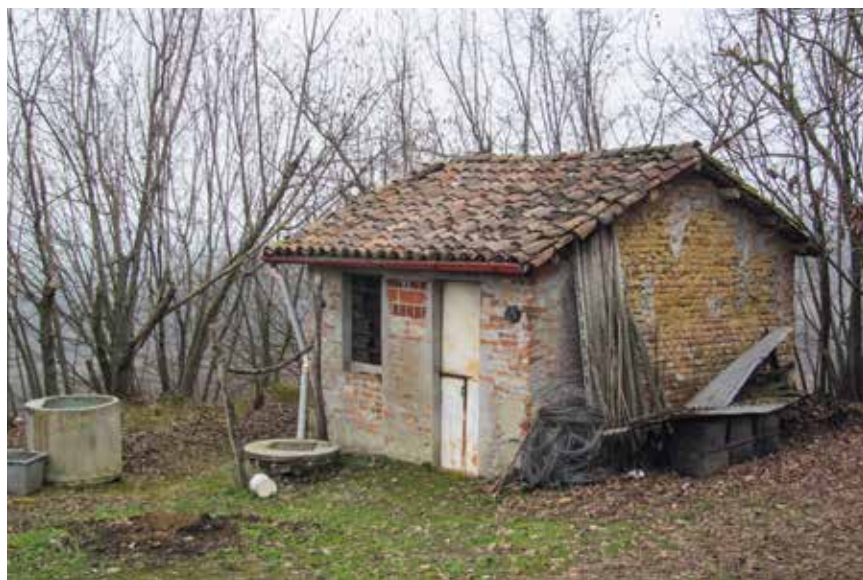
Figura 68: ciabòt con inserimento di nuova muratura in mattoni forati (intervento non compatibile)
