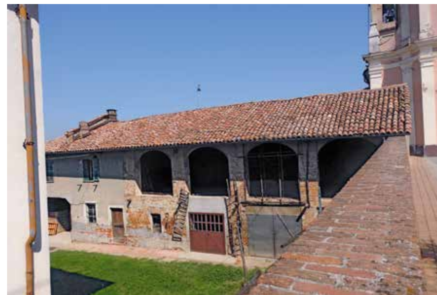
Figura 170: aperture ad arco con pilastrature in laterizio – Vaglio Serra
