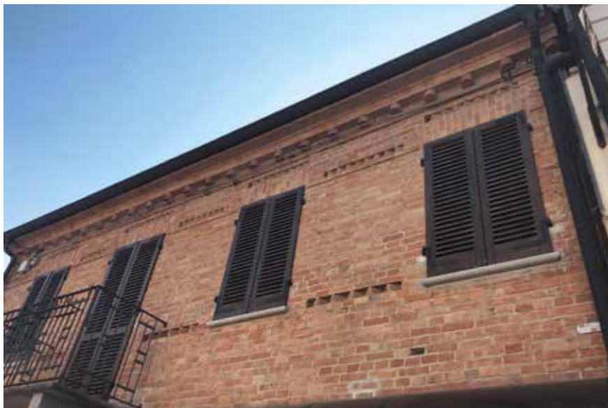
Figura 30: cornice in mattoni e elementi sagomati - Coazzolo
