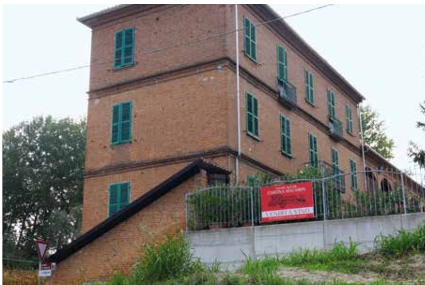
Figura 81: muratura in laterizio e fasce marcapiano - Isola d'Asti
