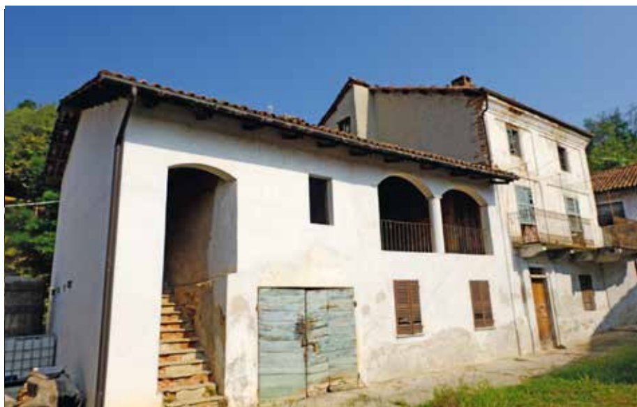
Figura 168: edificio di servizio con aperture ad arco – Belveglio
