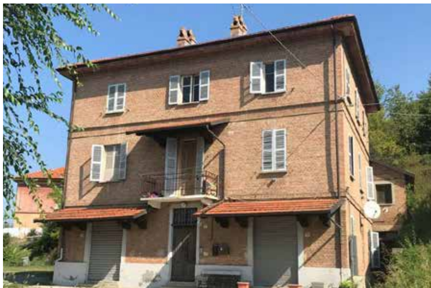
Figura 207: balcone con soletta intonacata, con inserimento di copertura in facciata
