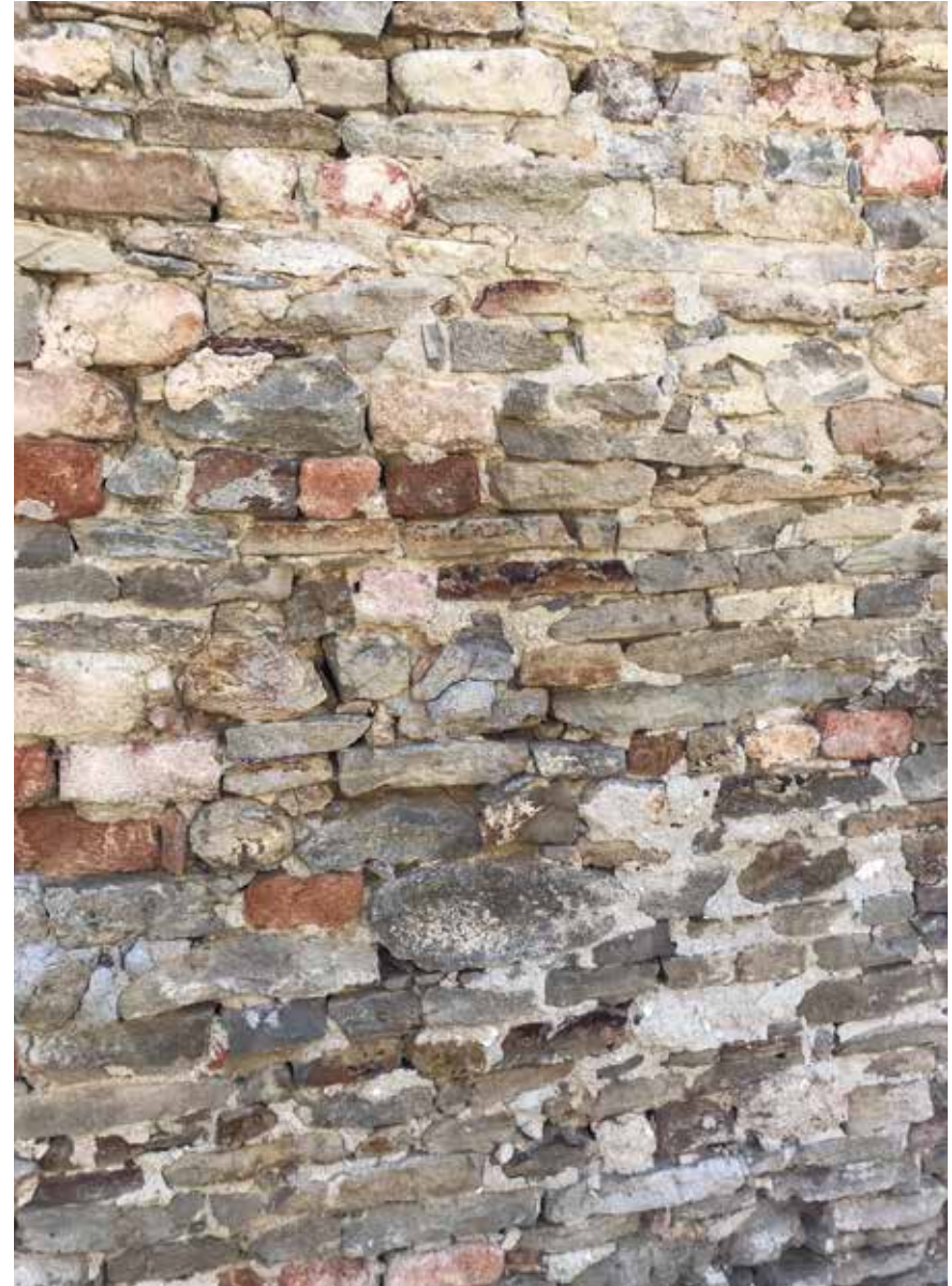
Figura 100: tessitura muraria, pietra e inserti in laterizio - Calamandrana
