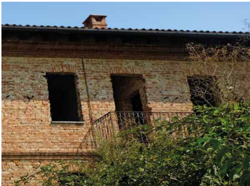
Figura 145: finestre con piattabanda in conci di laterizio - Belveglio
