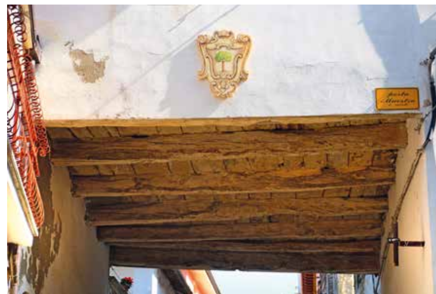
Figura 219: passaggio coperto con solaio con travi e pavimentazione - Fontanile
