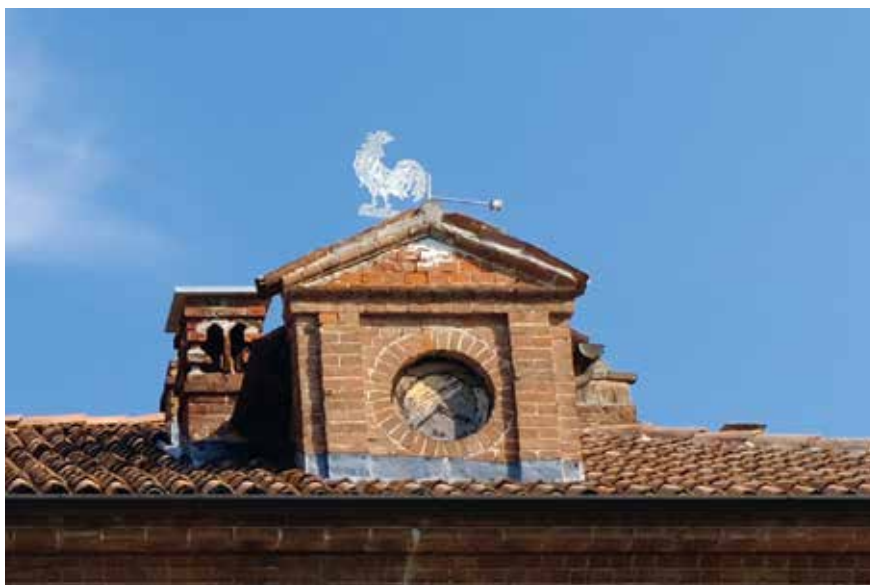
Figura 41: abbaino in mattoni e apertura circolare - Mombaruzzo
