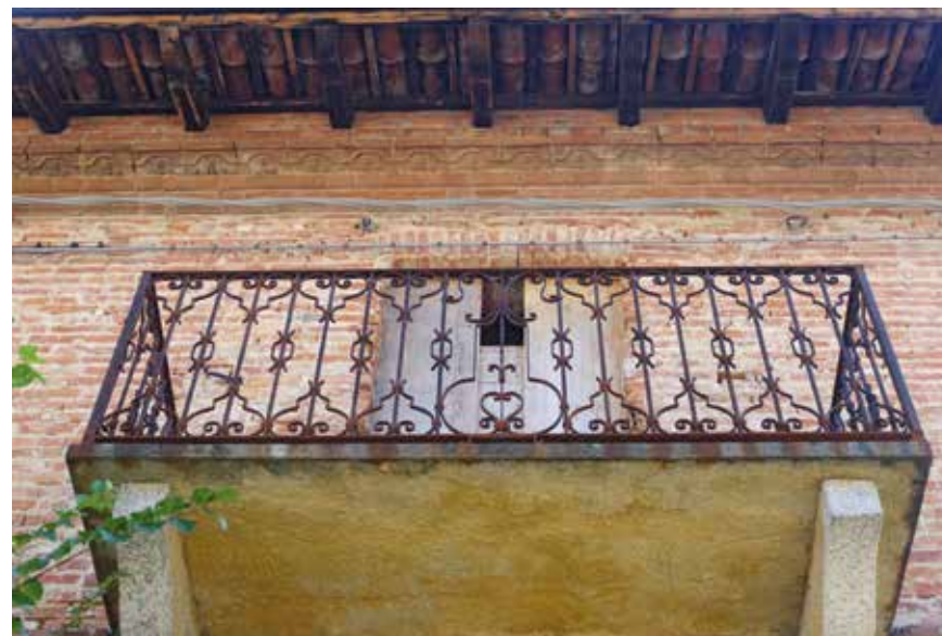
Figura 7: sporto del tetto con mensole passafuori sagomate - Belveglio
