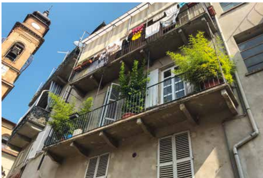
Figura 30: Edificio con ballatoio ai due piani superiori
