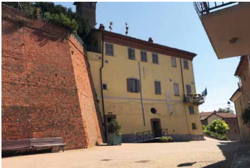
Figura 51: Muraglione addossato a palazzo
