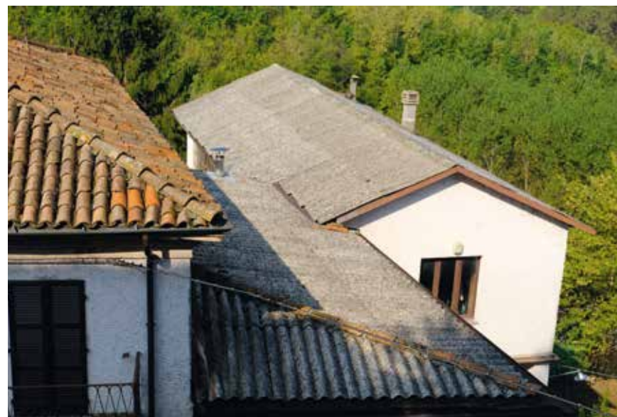
Figura 62: tetto in lastre di fibrocemento
