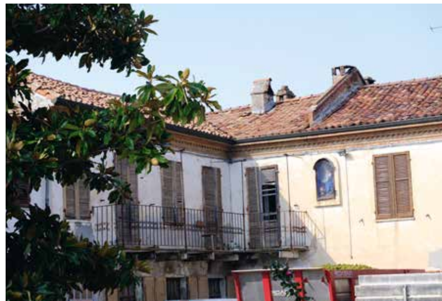
Figura 56: muro tagliafuoco di separazione tra unità abitative - Coazzolo
