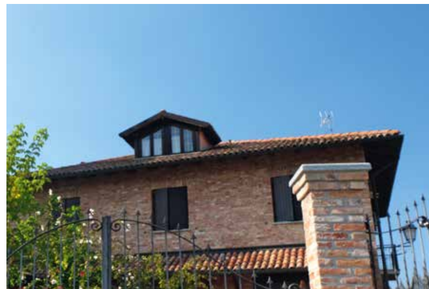
Figura 72: abbaino non conforme alla tradizione (pendenza, larghezza e ripartizione della finestra)
