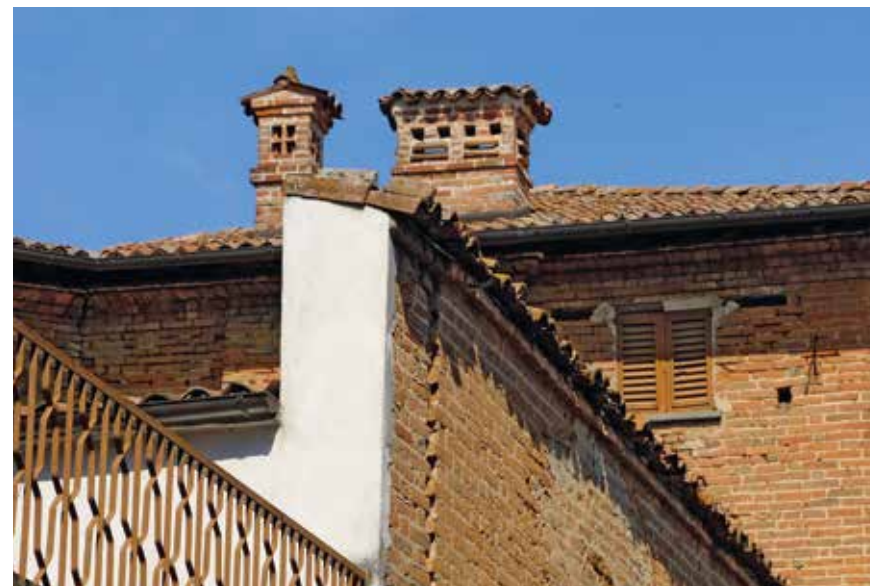
Figura 45: comignoli con copertura a capanna e piana - Mombaruzzo
