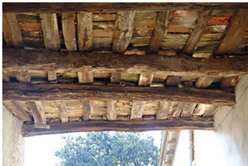
Figura 218: passaggio coperto con solaio con travi e travetti in legno – Cortiglione
