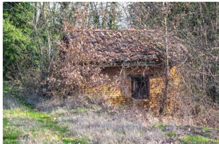
Figura 58: ciabòt nei boschi, con muratura in mattoni e serramento posto lungo la linea di gronda, con architrave ligneo
