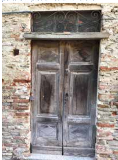
Figura 153: portoncino con architrave in legno e soprauce con inferriata
