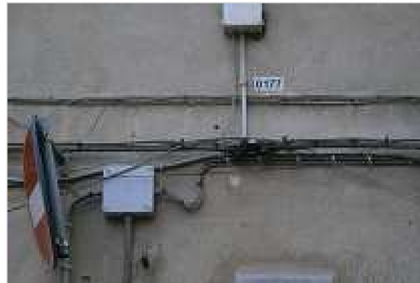
Figura 83: Cavi telefonici e dell'energia elettrica sulle facciate dei centri storici
