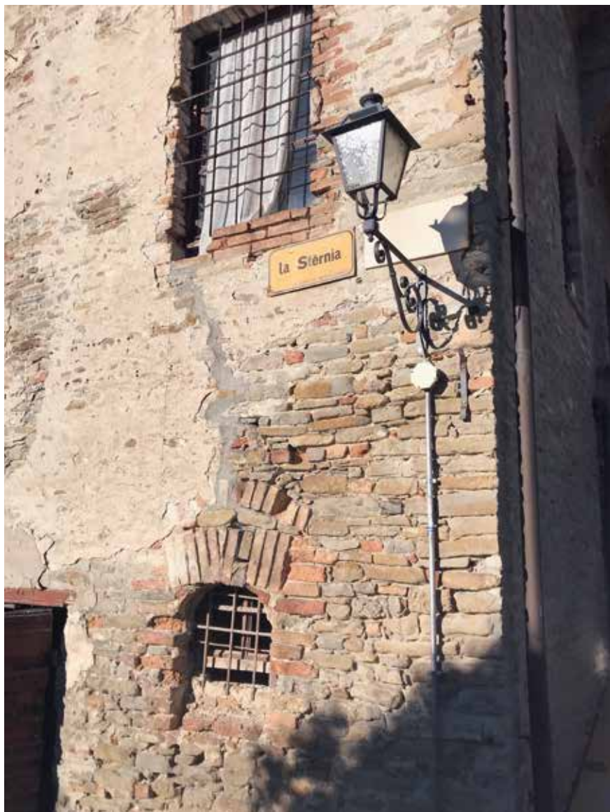
Figura 108: muratura in pietra - Canelli
