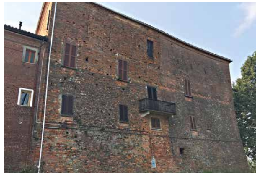
Figura 91: muratura in laterizio - Vigliano d'Asti
