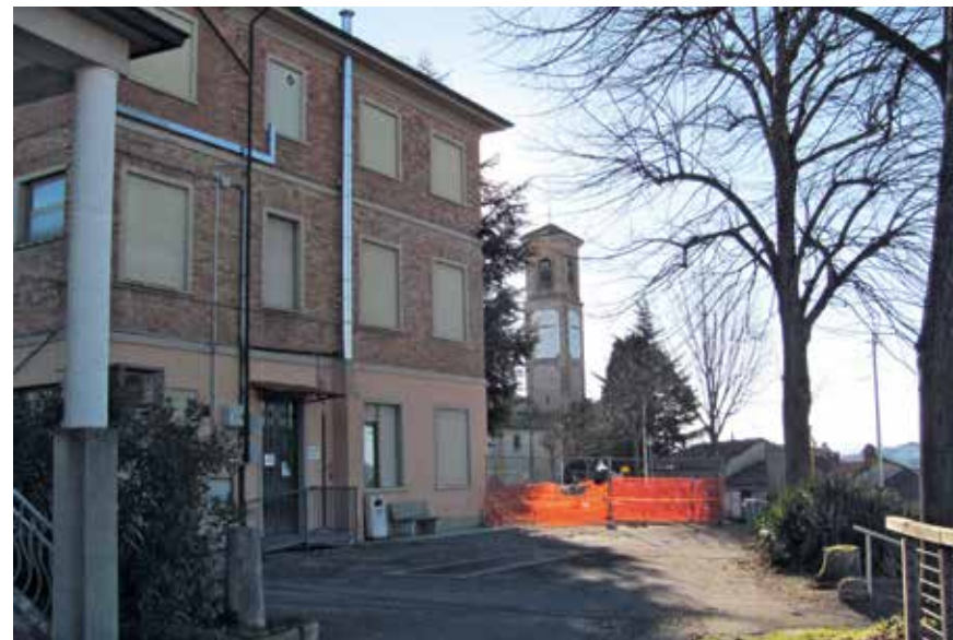
Figura 119: La facciata del palazzo comunale sul lato ovest prima dell'intervento
