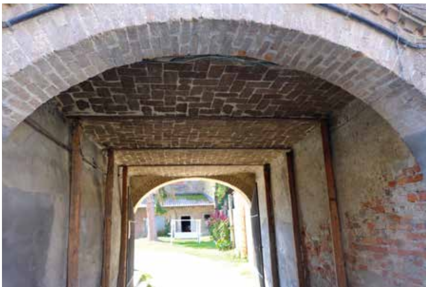
Figura 222: passaggio con solaio in voltini di mattoni Castelnuovo Belbo
