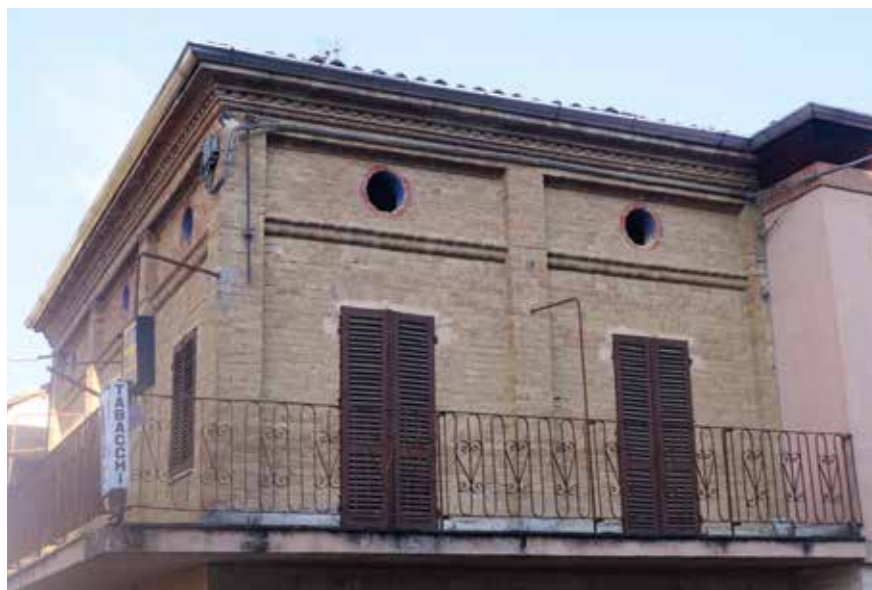
Figura 136: piccole aperture tonde per sottotetto – Castelnuovo Calcea
