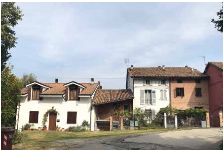
Figura 70: scorretto inserimento di abbaini (dimensioni non proporzionate e taglio della falda)
