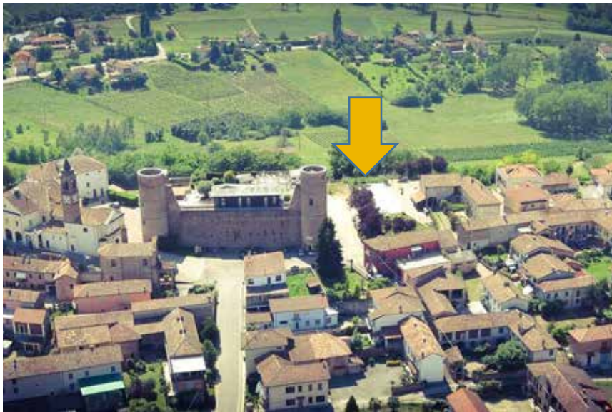
Figura 128: Panorama di Moasca dopo l'abbattimento della torre
