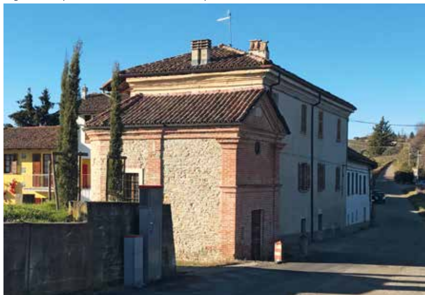
Figura 104: muratura in pietra e inserti in laterizio – Canelli
