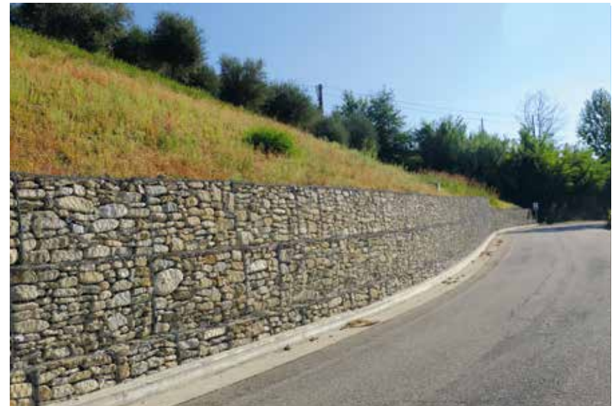
Figura 47: gabbionata a Vinchio
