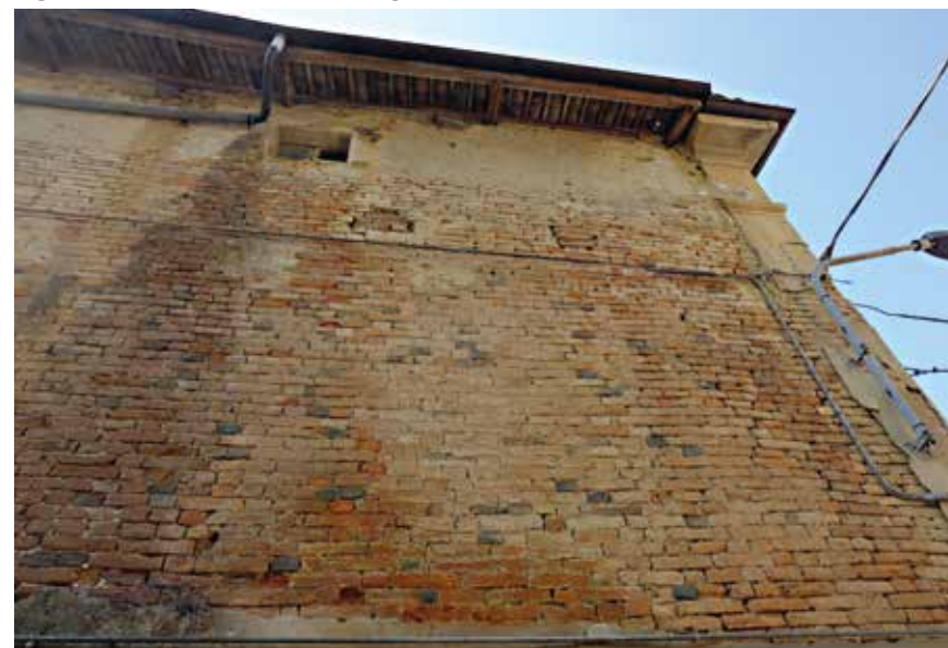
Figura 83: muratura in laterizio, posti di coltello e di testa - Belveglio
