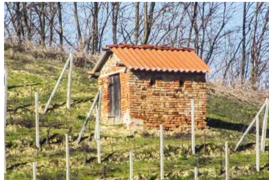
Figura 69: ciabòt con inserimento di copertura in lamiera (intervento non compatibile)
