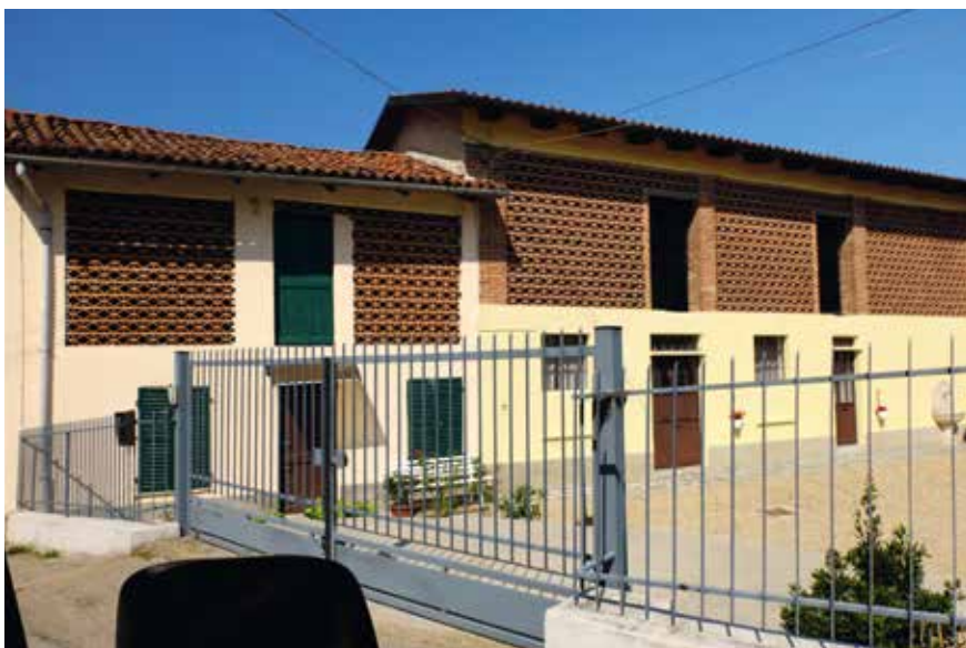
Figura 112: pareti grigliate con elementi in laterizio sagomato - Azzano d'asti
