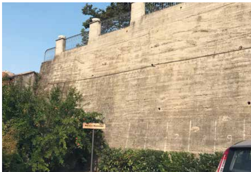
Figura 46: Muraglione in cemento armato
