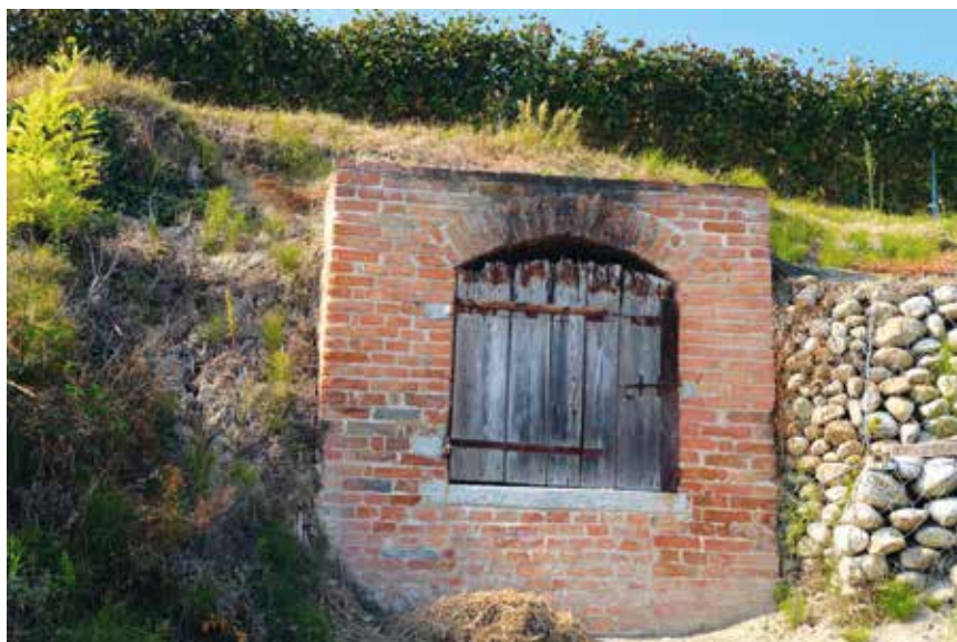
Figura 4: pozzo a muro - Castelnuovo Belbo
