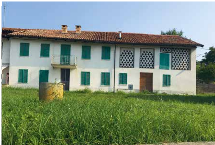
Figura 171: aperture rettangolari tamponate da muri gliigliati - Castagnole
