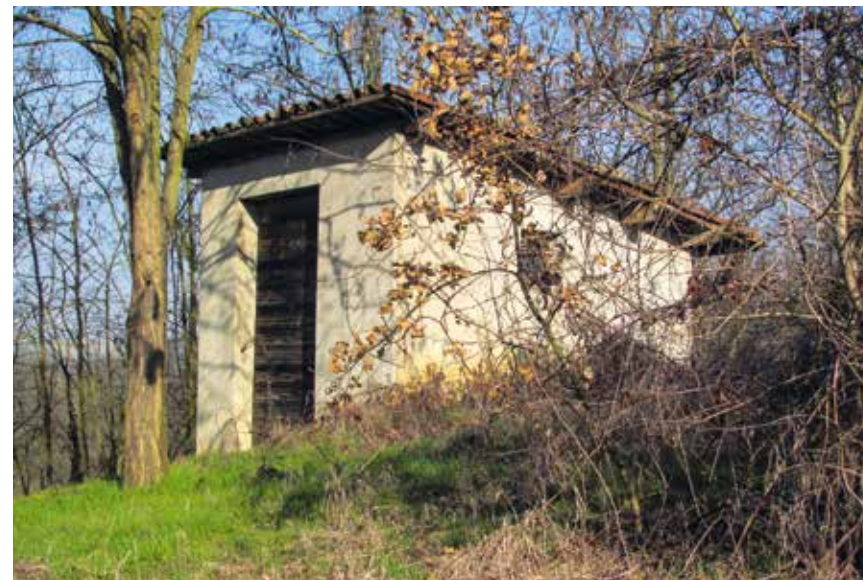
Figura 70: recupero totale con intonacatura della muratura (intervento da valutare in base alla preesistenza)
