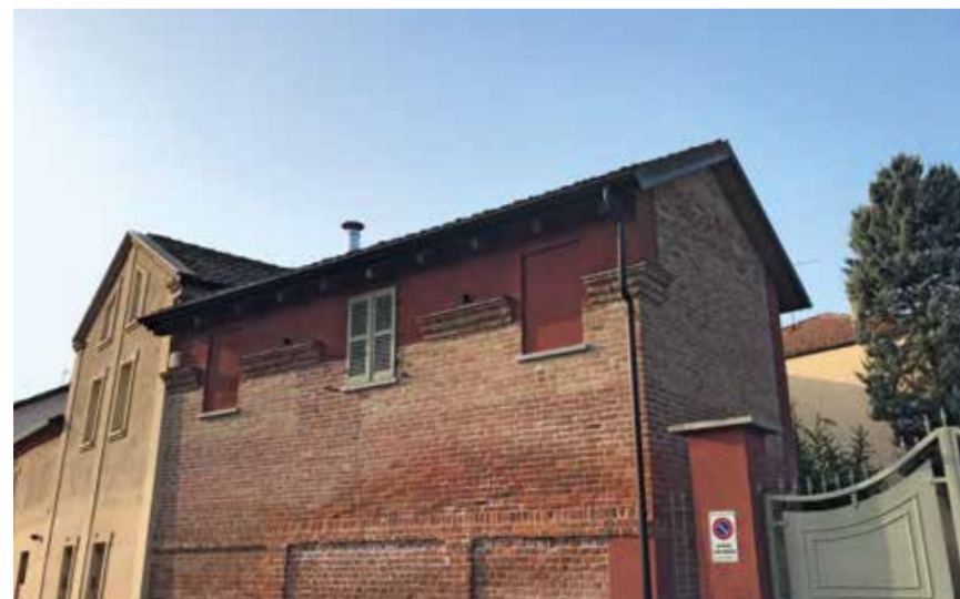
Figura 186: trattamento non compatibile delle tamponature in rapporto alla configurazione di facciata
