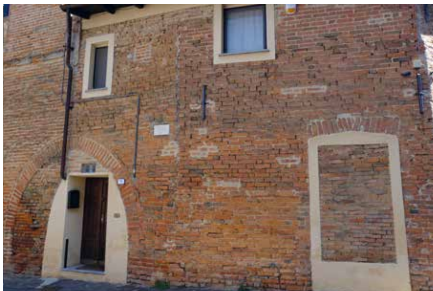
Figura 176: inserimento di decori intonacati non congrui e scorretto tamponamento delle aperture
