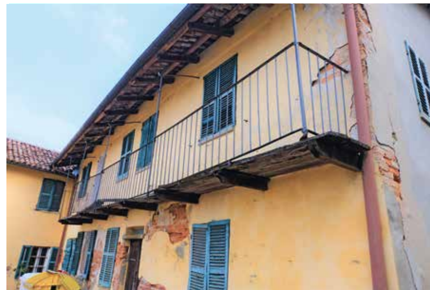
Figura 3: sporto del tetto su ballatoio passa fuori – Isola d’Asti
