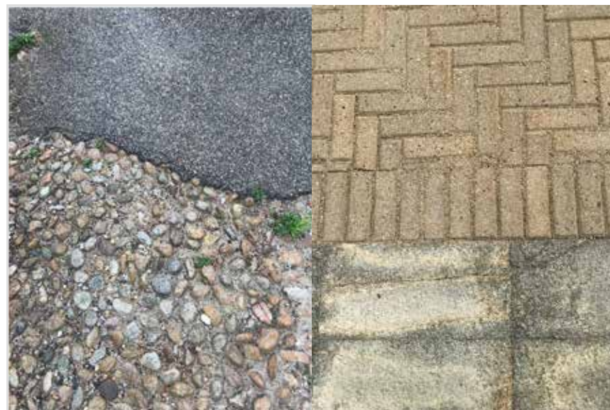
Figura 95: Accostamenti tra ciottoli e asfalto e tra blocchetti e lastre di cemento
