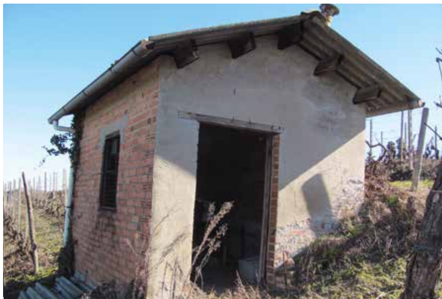
Figura 71: ciabòt con inserimento di muratura in laterizio forato e copertura in lamiera (intervento non compatibile)
