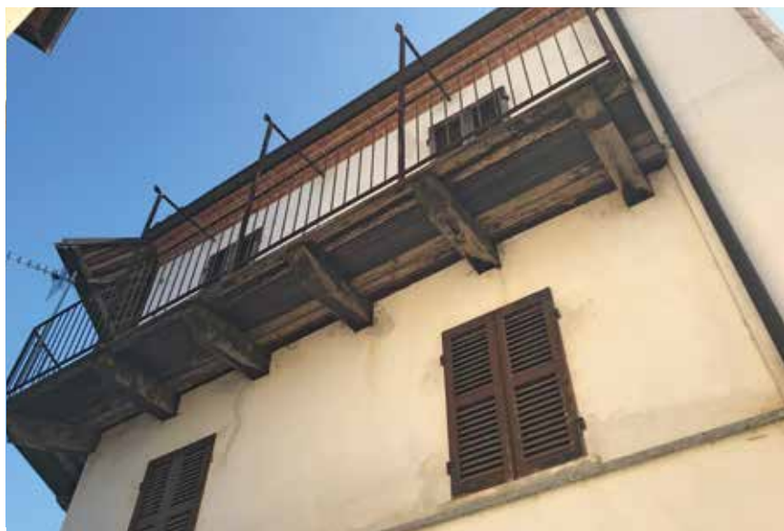
Figura 199: ballatoio in legno - Montegrosso
