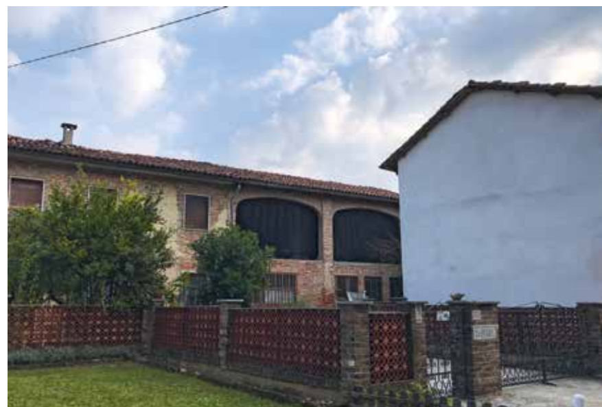
Figura 14: Casa rurale in linea alterata da interventi non coerenti
