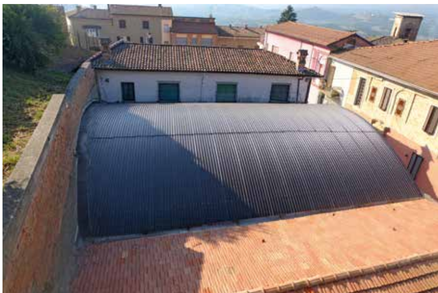
Figura 79: scorretto inserimento di nuova copertura in centro urbano
