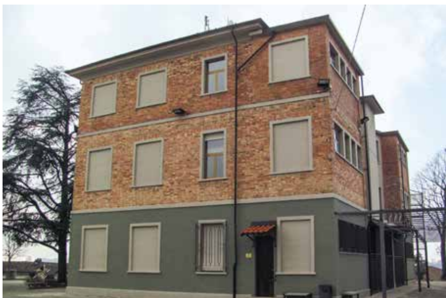
Figura 118: La facciata del palazzo comunale dopo l'intervento con i nuovi colori
