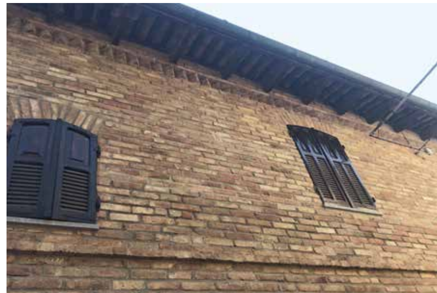
Figura 93: muratura in corsi regolari - Incisa Scapaccino
