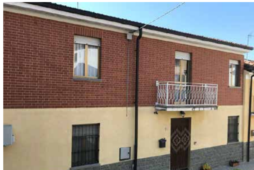
Figura 209: soletta in ca e tipologia di ringhiera incoerente
