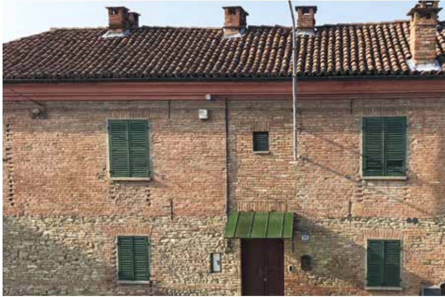
Figura 98: muratura in pietra (piano terra) e laterizio – Castagnole
