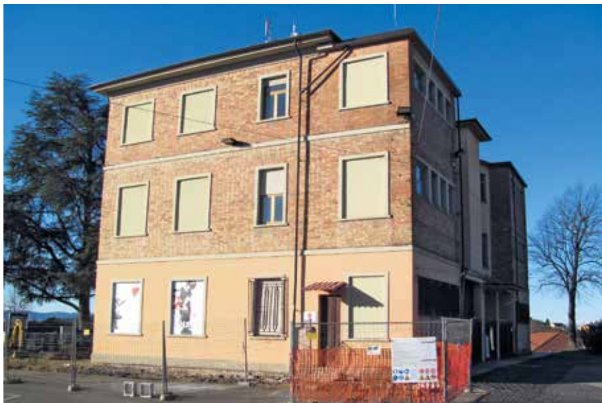
Figura 117: La facciata del palazzo comunale prima dell'intervento
