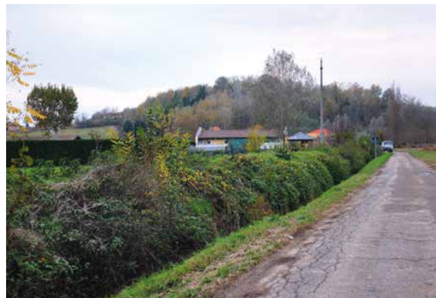
Figura 63: fosso irriguo a bordo strada a Mombercelli
