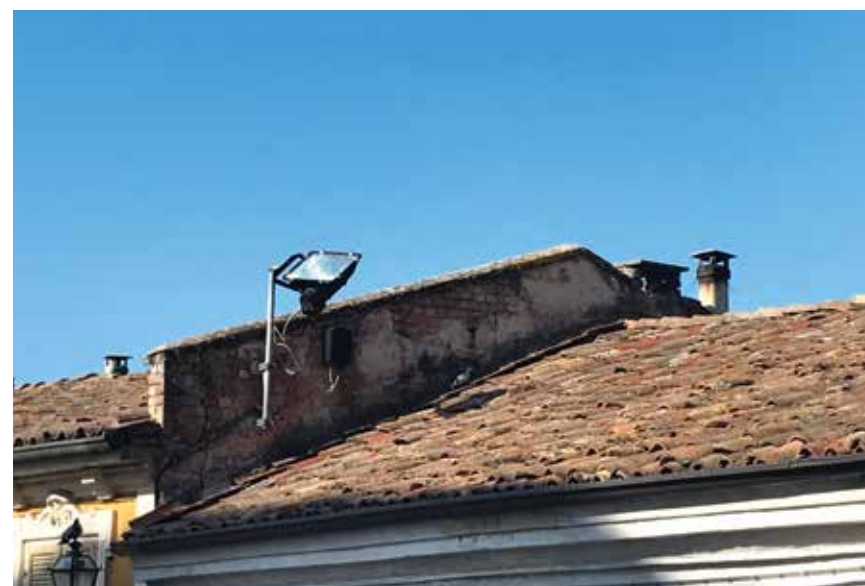
Figura 52: particolare muro tagliafuoco con rivestimento in mattoni – Montegrosso d'Asti
