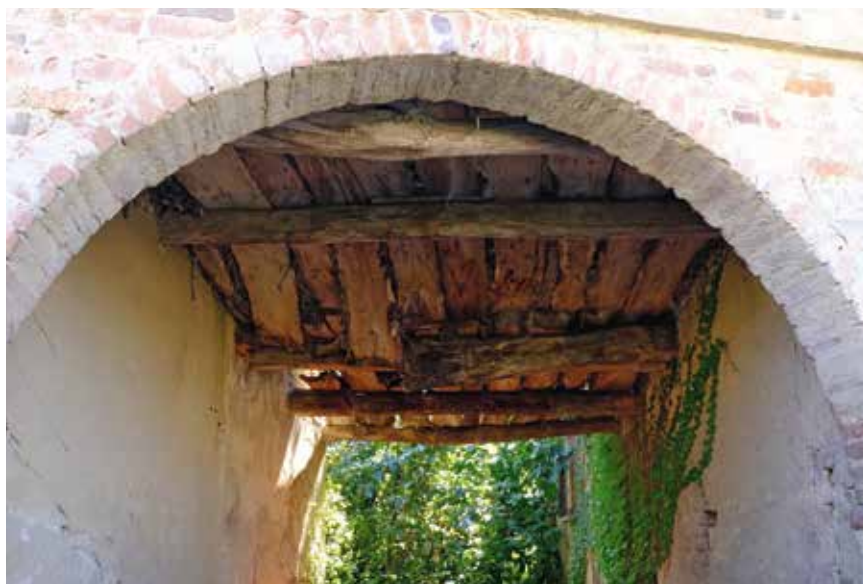
Figura 217: passaggio coperto con solaio in travi e assi di legno – Mombercelli
