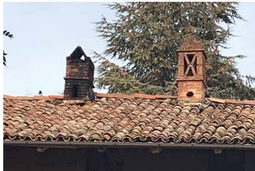
Figura 50: comignolo con copertura piramidale (dx) – Agliano Terme
