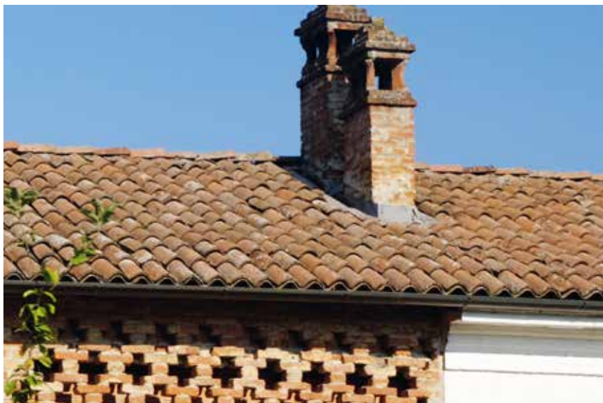
Figura 47: comignolo con copertura poggiate su gambette in elementi di laterizio - Mobaruzzo
