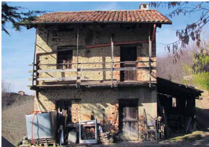
Figura 62: ciabòt a due piani con muratura in terra cruda e ballatoio ligneo
