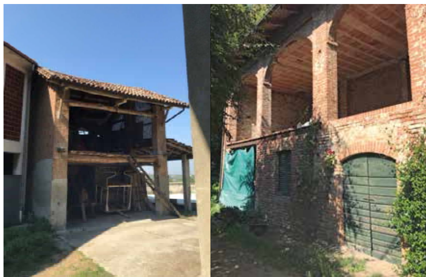
Figura 172: apertura rettangolare e aperture ad arco con pilastrature - Incisa Scapaccino
