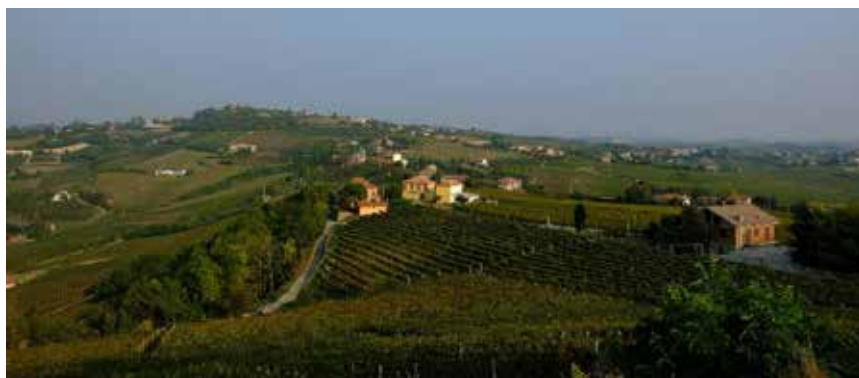
Figura 143: Elementi critici di disvalore: edificio in primo piano non corrispondente alla tradizione costruttiva tipica del luogo
