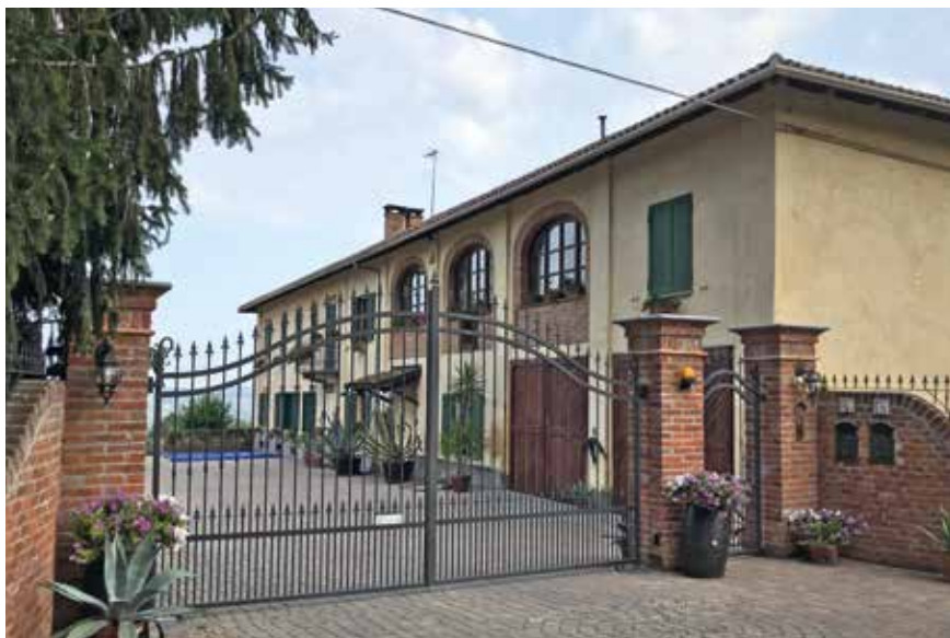
Figura 179: tamponamento errato delle aperture dei fienili
