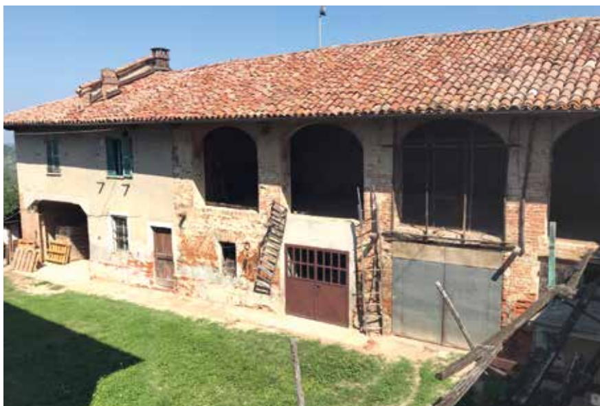
Figura 53: muro tagliafuoco di separazione tra stalla/fienile e abitazione – Vaglio Serra
