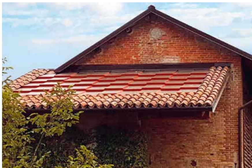
Figura 59: esempio di tetto con fotovoltaico integrato
