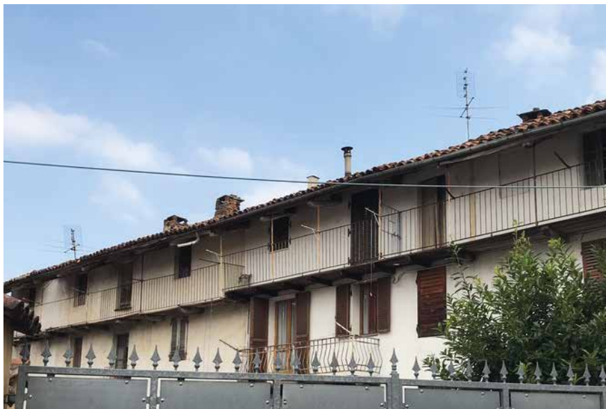
Figura 29: Edificio con ballatoio al piano superiore
