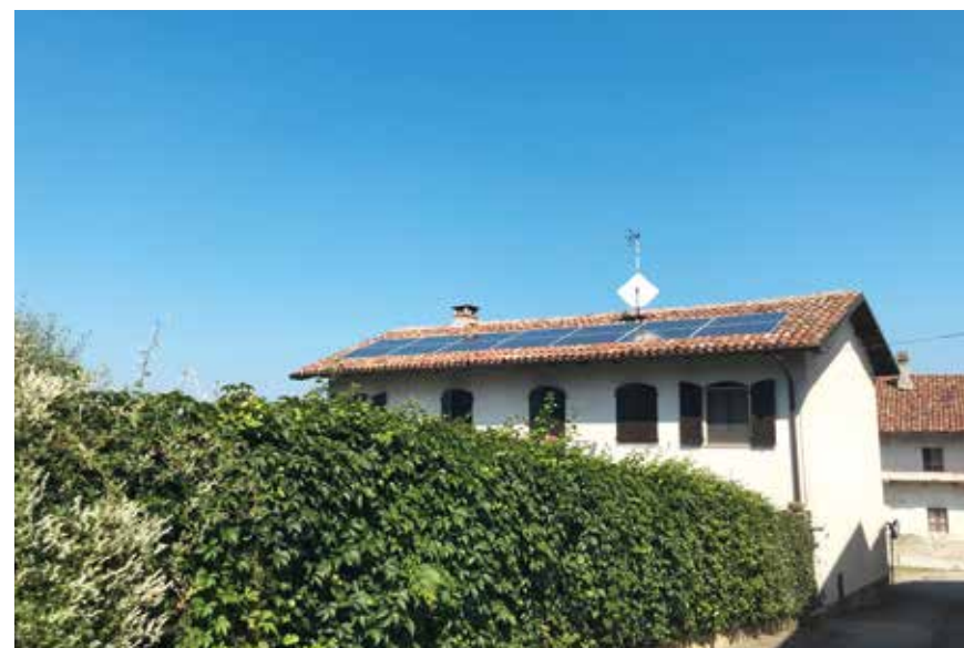
Figura 65: scorretto inserimento di pannelli fotovoltaici
