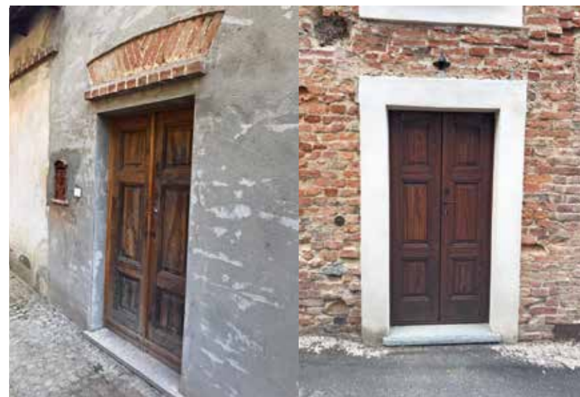
Figura 178: piattabanda a vista (sx); fascia decorativa non compatibile (dx)
