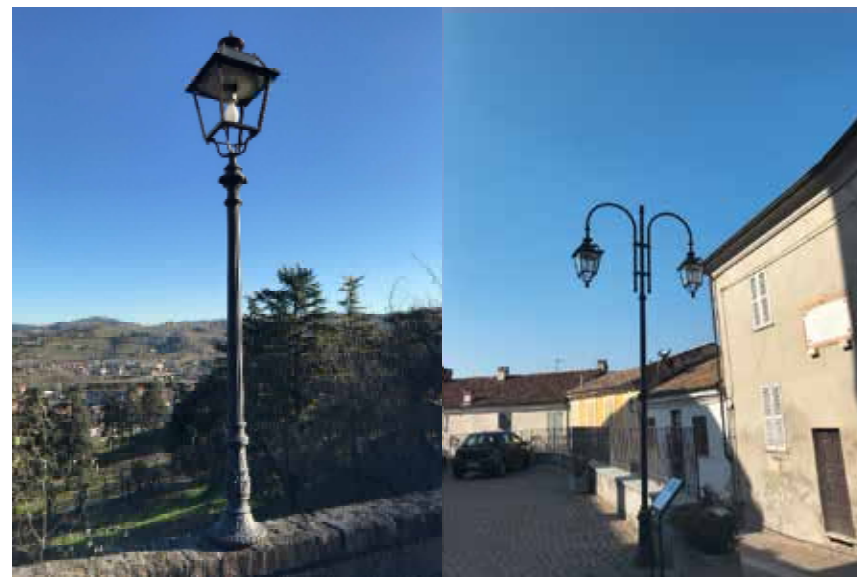
Figura 97: illuminazione con corpo illuminante su palo
