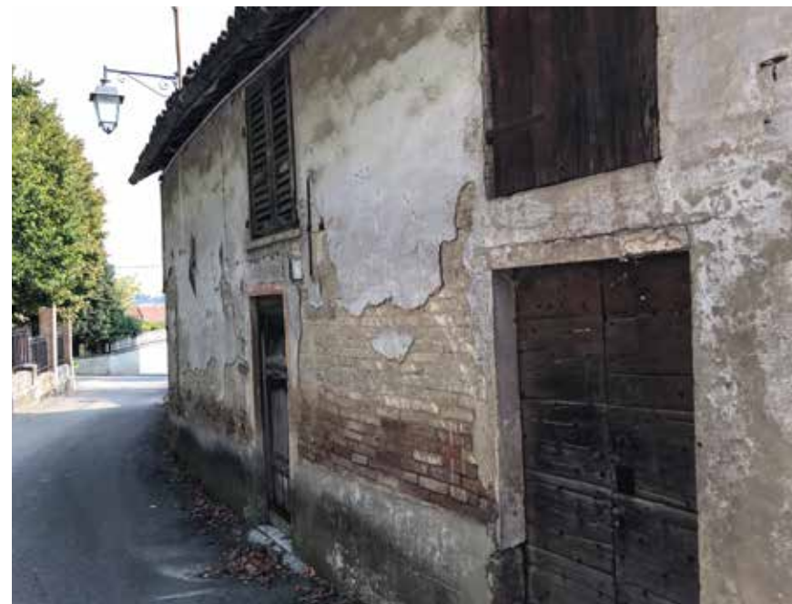
Figura 118: muratura in terra cruda - Castagnole
