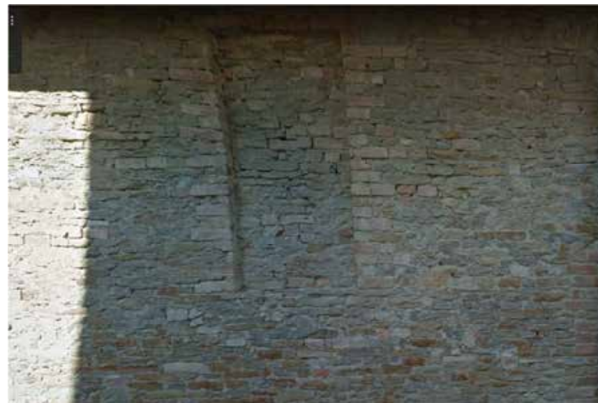
Figura 103: partolate tessitura muraria pietra – Calosso
