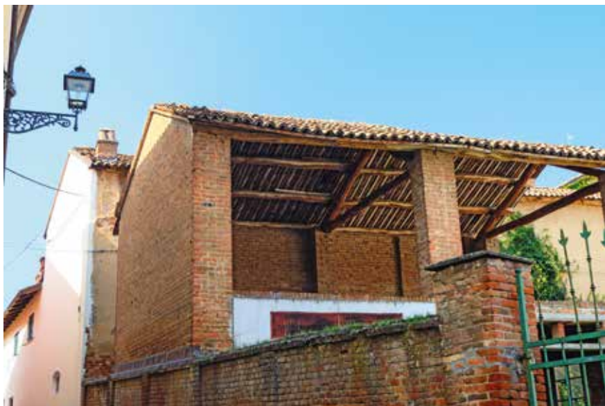
Figura 5: orditura alla lombarda con struttura a capriate – Castelletto Molina
