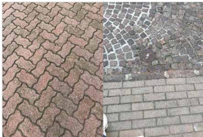
Figura 95: Autobloccanti in cemento e accostamenti tra blocchetti in porfido e in cemento
