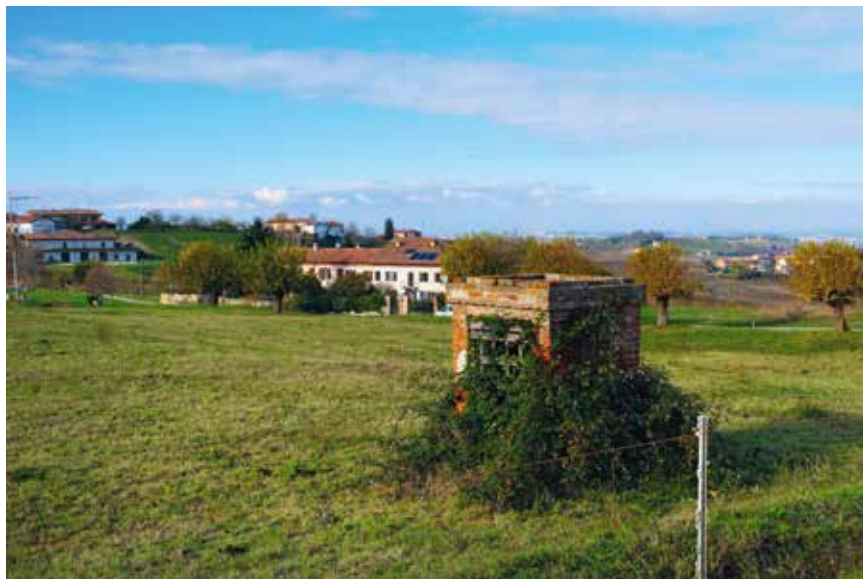
Figura 3: pozzo di forma quadrangolare in laterizio e tetto piano - Costigliole d'Asti
