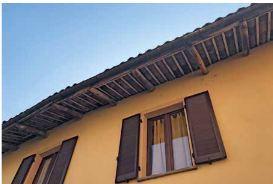
Figura 14: sporto del tetto con passafuori incastrati nella murature - Montegrosso d'Asti
