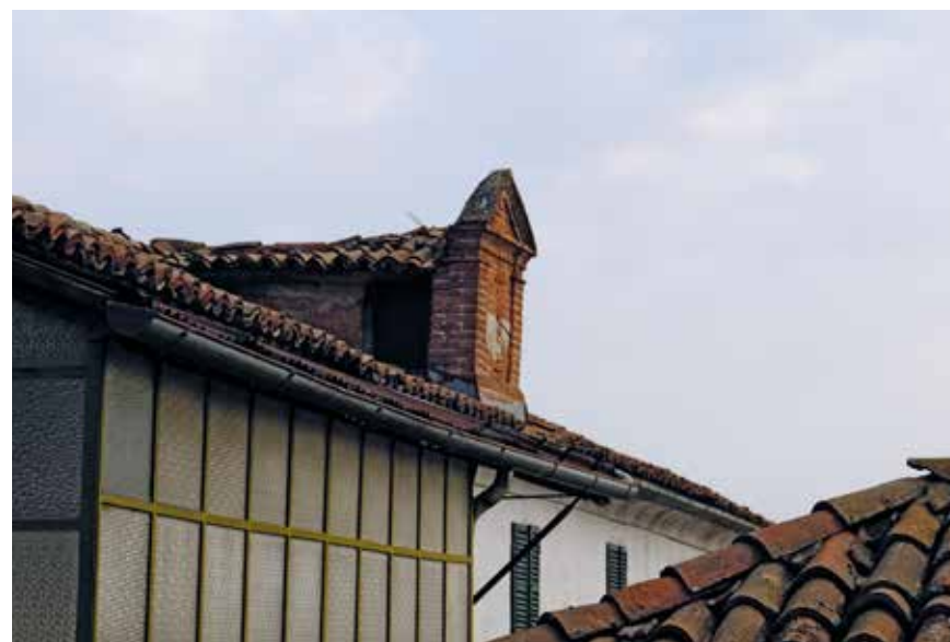
Figura 35: abbaino con fronte cieco in mattoni e timpano – Isola d'Asti
