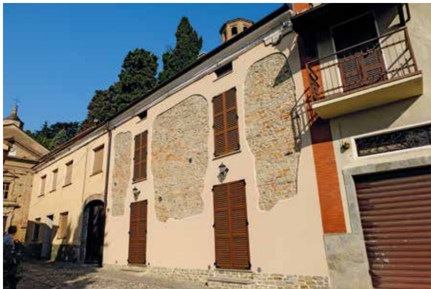
Figura 124: stesa dell'intonaco a macchia
