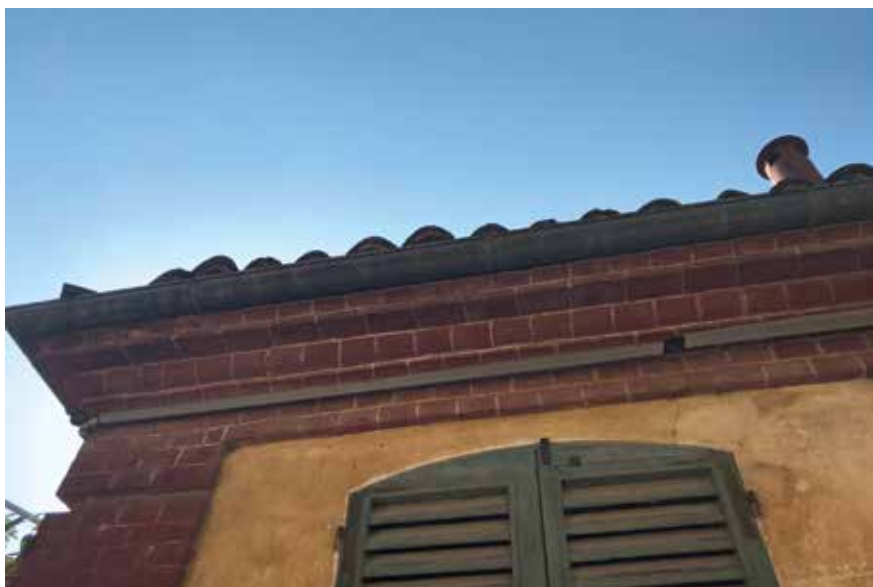
Figura 26: cornice in corsi di mattoni - Coazzolo
