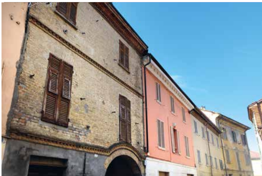
Figura 23: differenti cornicioni lungo la strada principale - Castelnuovo Belbo
