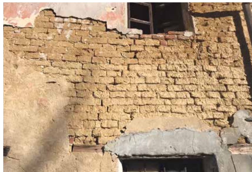
Figura 123: muratura in terra cruda intonacata
