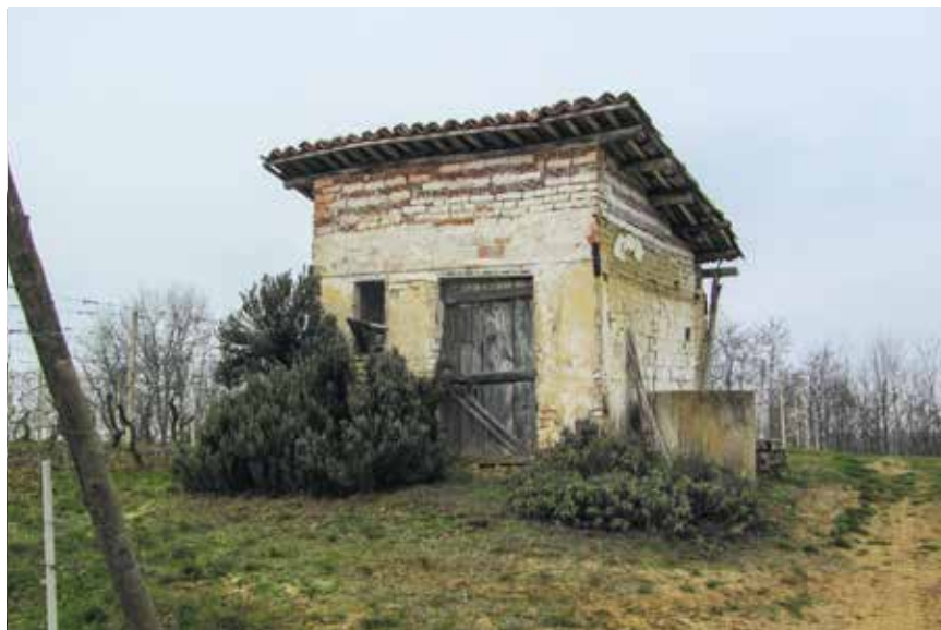
Figura 67: ciabòt con sopraelevazione in mattoni forati (intervento non compatibile)
