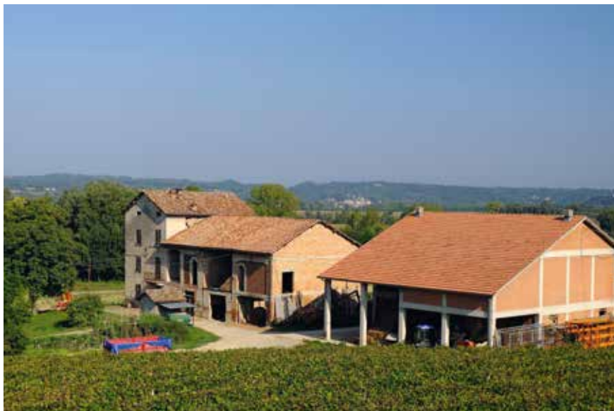
Figura 63: scorretto inserimento paesaggistico di nuove coperture (marsigliesi) rispetto alle coperture tradizionali in coppo
