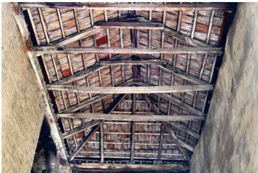
Figura 9: tetto a padiglione con struttura a capriate - Mombaruzzo
