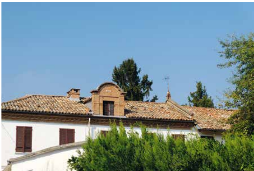
Figura 36: abbaino con lesene e coronamento curvo - Coazzolo
