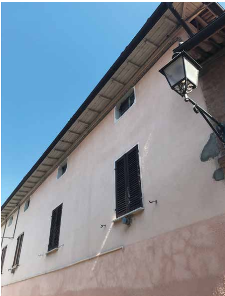
Figura 67: intonacatura dello sporto
