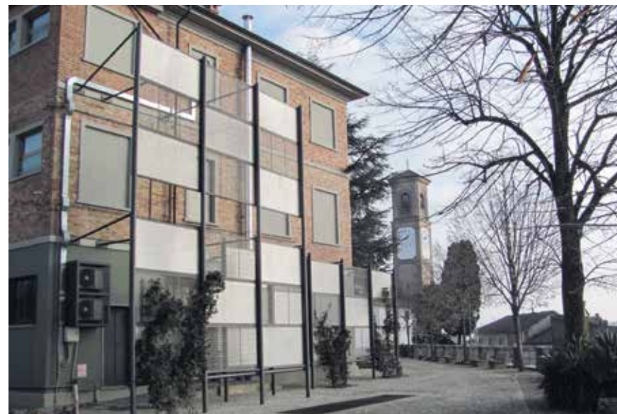
Figura 120: La facciata del palazzo comunale con la realizzazione della struttura di mascheramento
