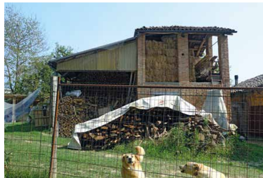
Figura 169: aperture rettangolari con pilastrature in laterizio - Belveglio
