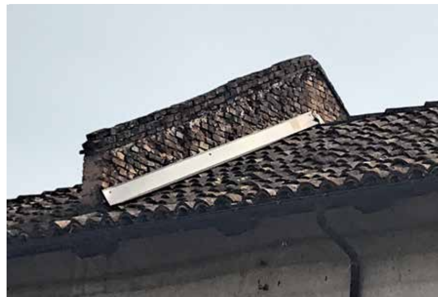
Figura 51: particolare muro tagliafuoco con rivestimento in mattoni - Costigliole
