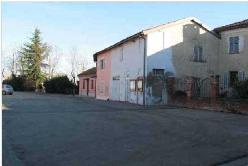
Figura 121: Facciate degli edifici privati prima dell'intervento
