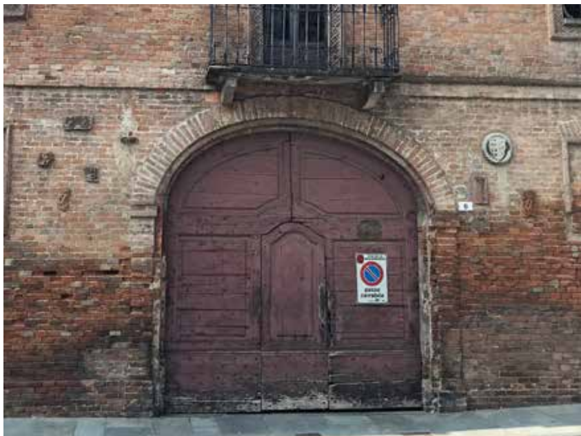
Figura 161: accesso carrabile con portoncino per l'accesso pedonale – Nizza Monferrato
