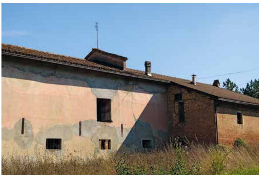
Figura 54: muro tagliafuoco – Quaranti
