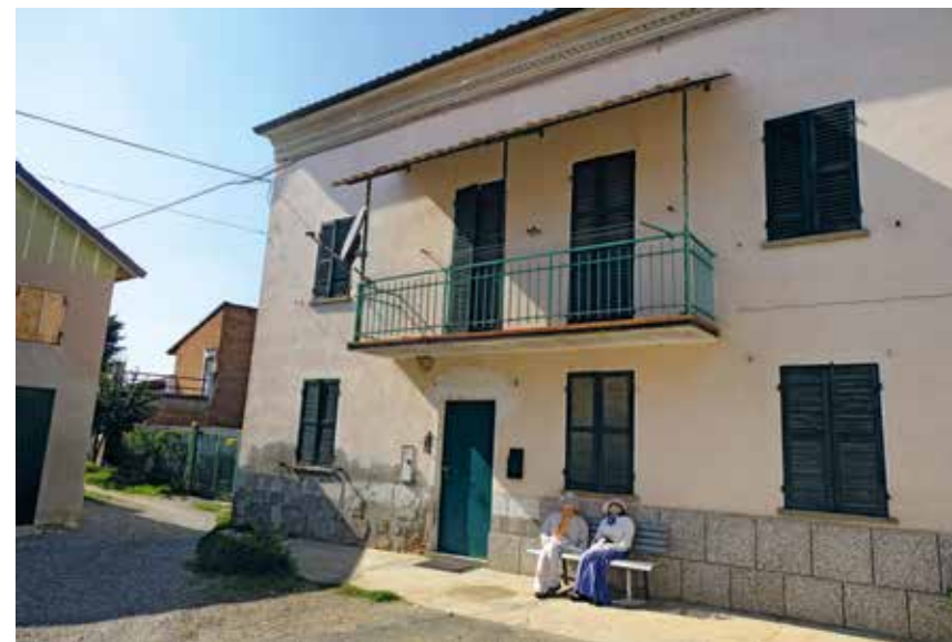
Figura 205: pavimentazione a vista
