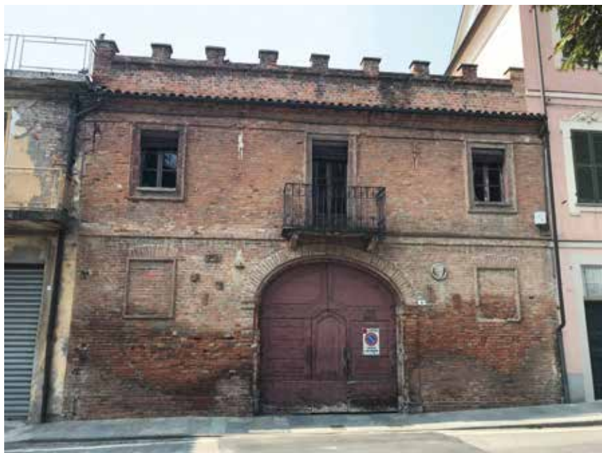
Figura 188: balcone centrale al primo piano sopra porta di ingresso – Nizza Monferrato
