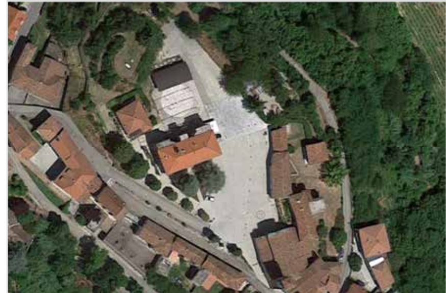
Figura 111: Il sito oggetto dei lavori di riqualificazione
