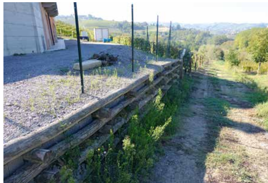
Figura 44: palificata a parete doppia - Calosso
