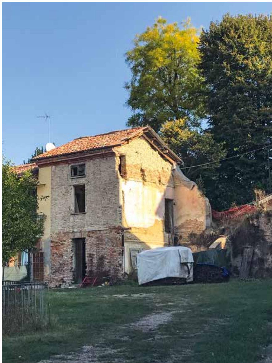
Figura 117: muratura in terra cruda – Montegrosso
