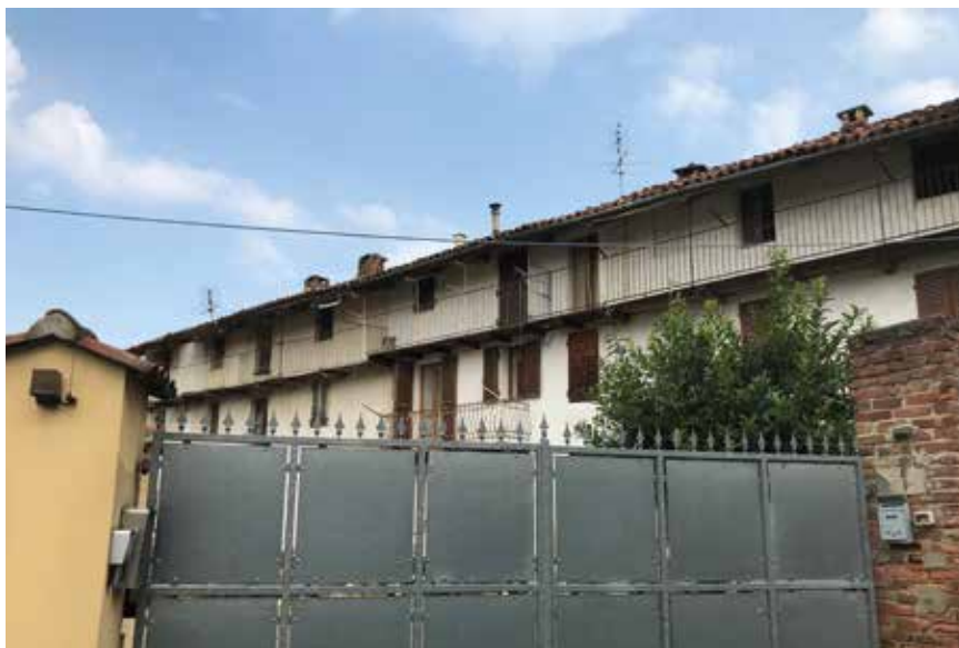
Figura 197: ballatoio su cortile interno - Mongardino
