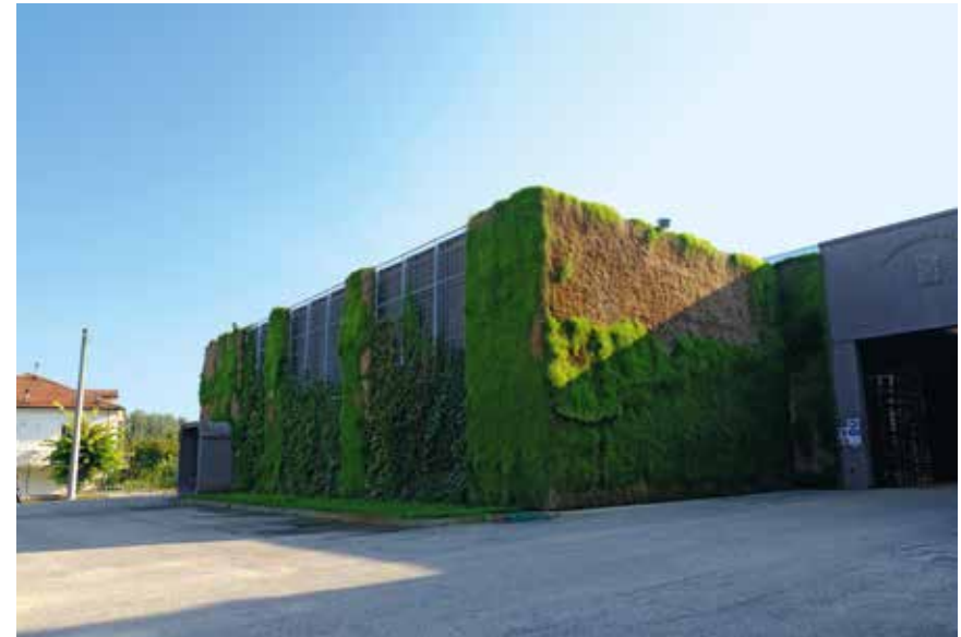
Figura 30: muro verde a Nizza Monferrato
