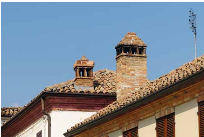
Figura 43: comignolo con copertura a 4 falde poggianti su sostegni di laterizio - Coazzolo
