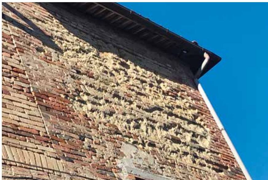
Figura 120: muratura in terra cruda e laterizio – Vinchio
