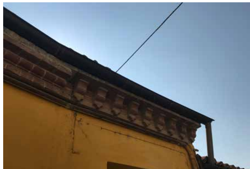
Figura 28: cornice con elementi sagomati - Coazzolo
