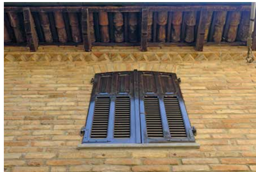
Figura 11: sporto del tetto con mensole in legno passafuori - Incisa Scapaccino
