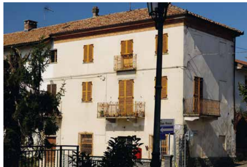
Figura 16: cornicione in corso di mattoni regolari – Montegrosso d'Asti
