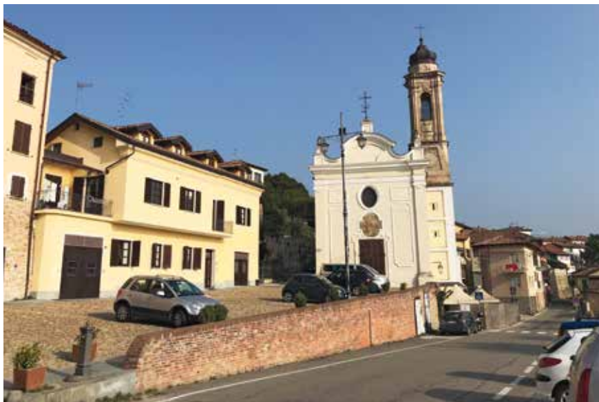
Figura 80: Piazzale e sagrato sopra muro
