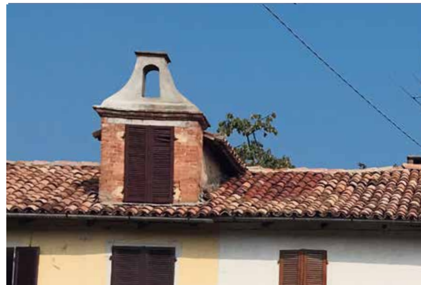
Figura 38: abbaino con coronamento sporgente - Castagnole
