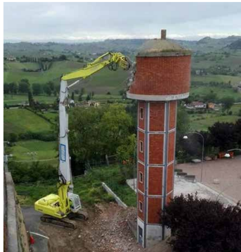
Figura 127: Abbattimento della torre
