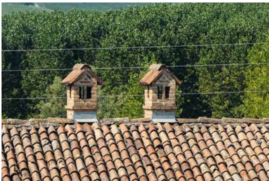
Figura 44: comignolo con copertura a capanna in coppi - Canelli
