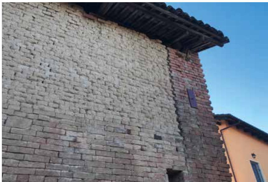
Figura 121: muratura con piano terra in laterizio e piano superiore in terra cruda – Vinchio
