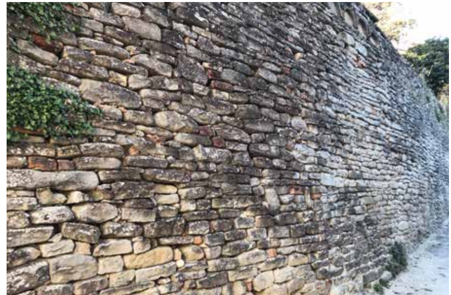
Figura 107: tessitura muraria – Canelli
