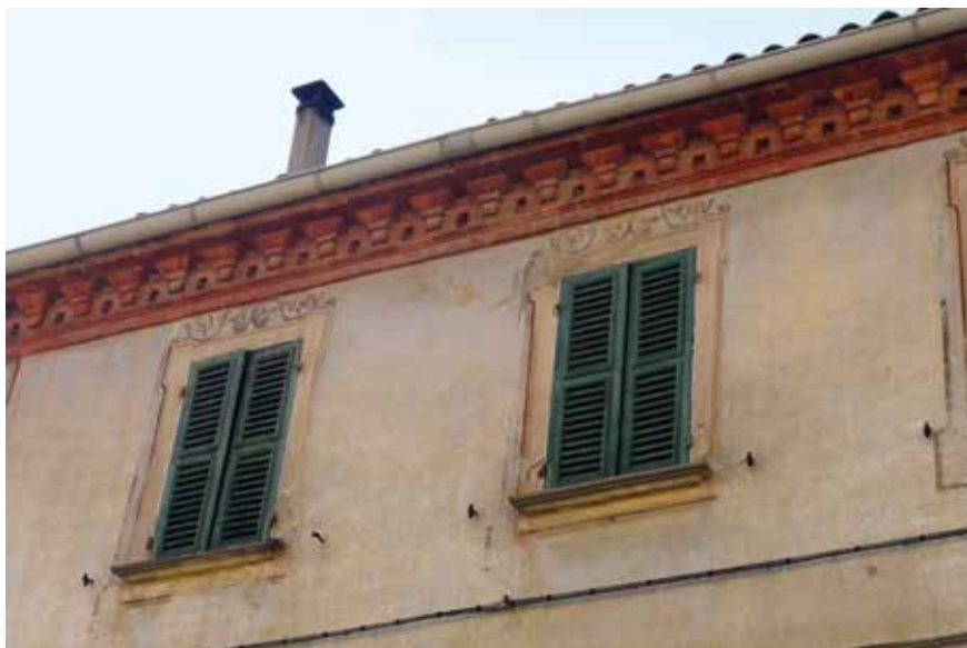
Figura 22: cornice con elementi in cotto sagomati - Calamandrana
