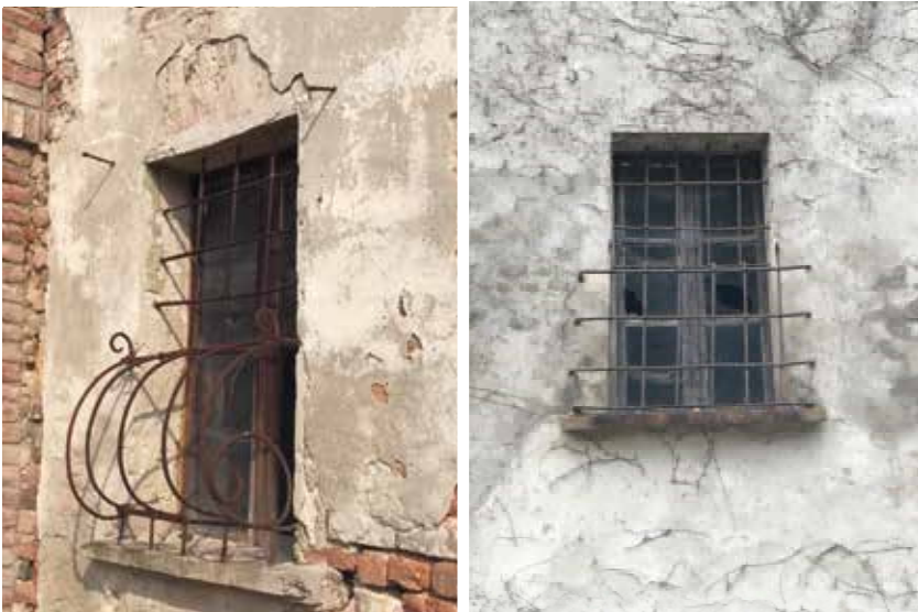
Figura 147: inferriata con base bombata e con maglia ortogonale
