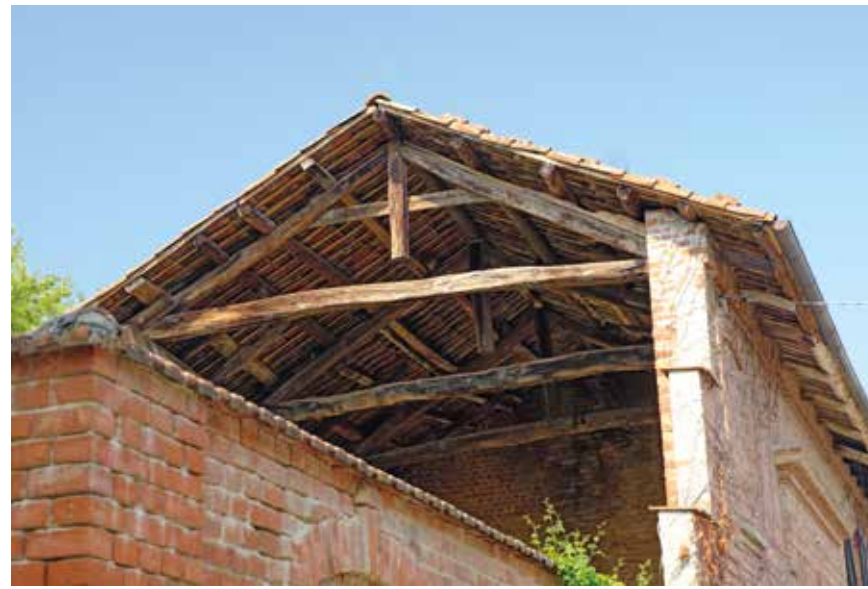
Figura 8: orditura alla lombarda con struttura a capriate – Rocchetta Tanaro
