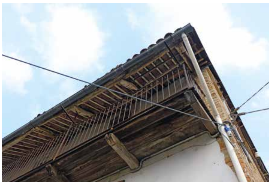
Figura 200: particolare di ballatoio in legno - Mongardino
