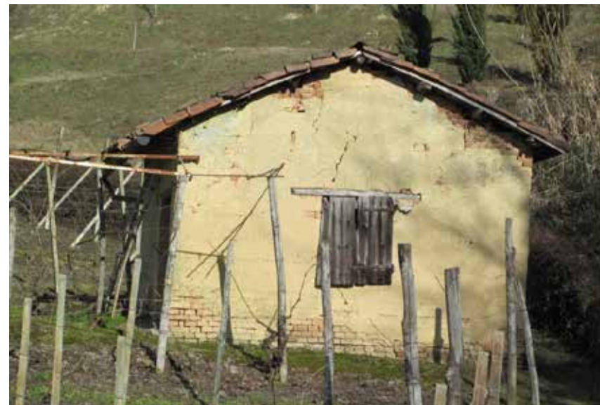
Figura 53: ciabòt con muratura in laterizio intonacata, con ingresso posto in corrispondenza della linea di gronda; serramento con architrave ligneo e scuri in legno
