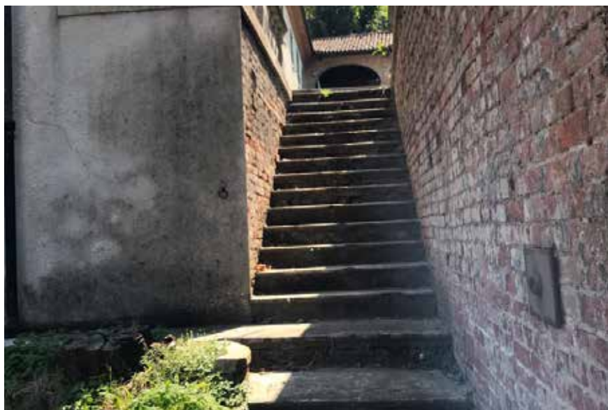
Figura 48: Scala di collegamento tra via e piazzale
