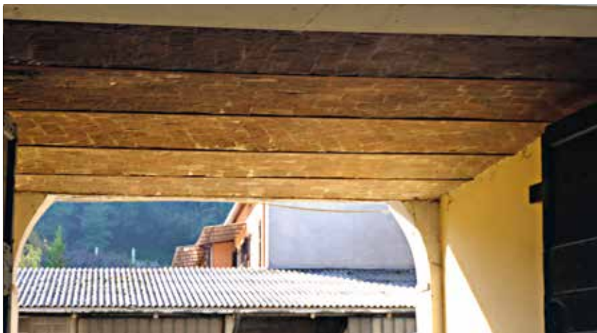
Figura 221 passaggio con solaio in voltini di mattoni Calamandrana
