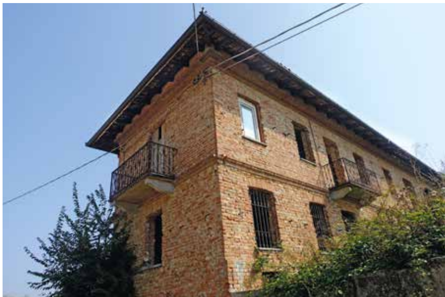
Figura 84: muratura in laterizio e cornici marcapiano - Belveglio
