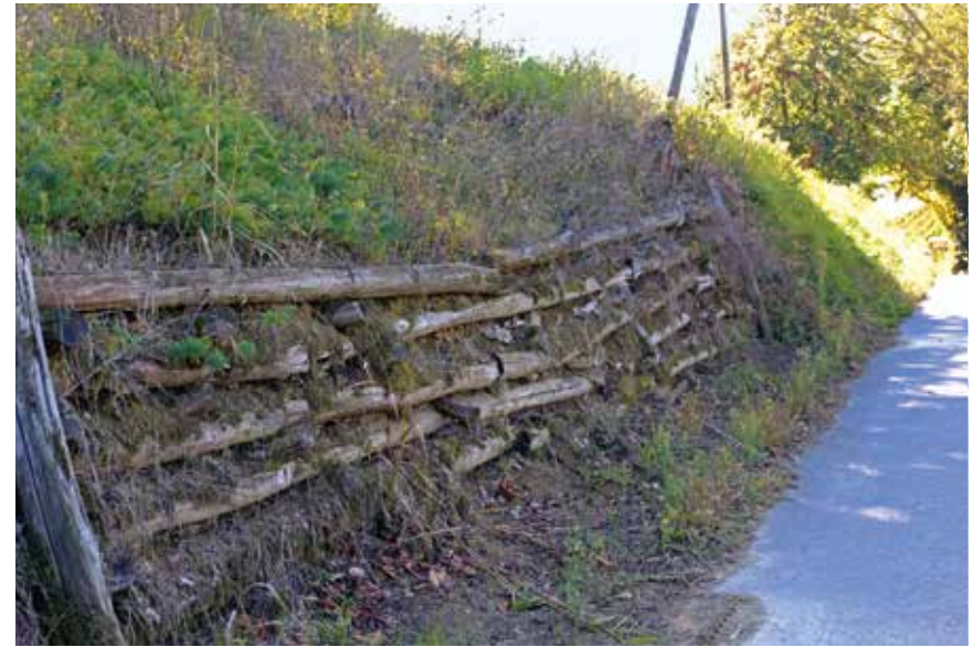
Figura 40: palificata degradata a parete semplice - Mombercelli
