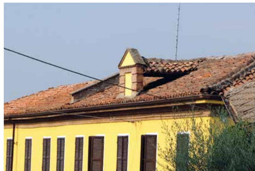
Figura 66: abbaino con rifacimento non conforme
