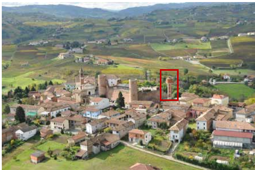
Figura 125: Foto del Castello e della torre prima di essere abbattuta
