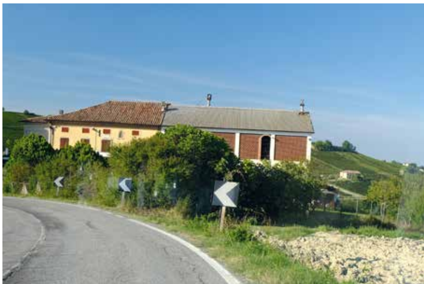
Figura 75: scorretto inserimento paesaggistico di nuova copertura in ambito rurale
