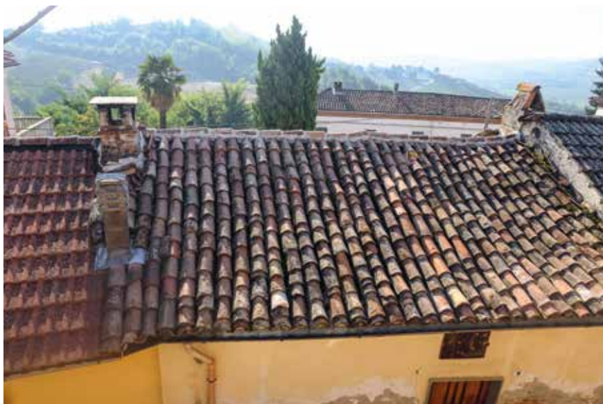
Figura 64: accostamento di diverse coperture (marsigliesi, coppi, fibrocemento)
