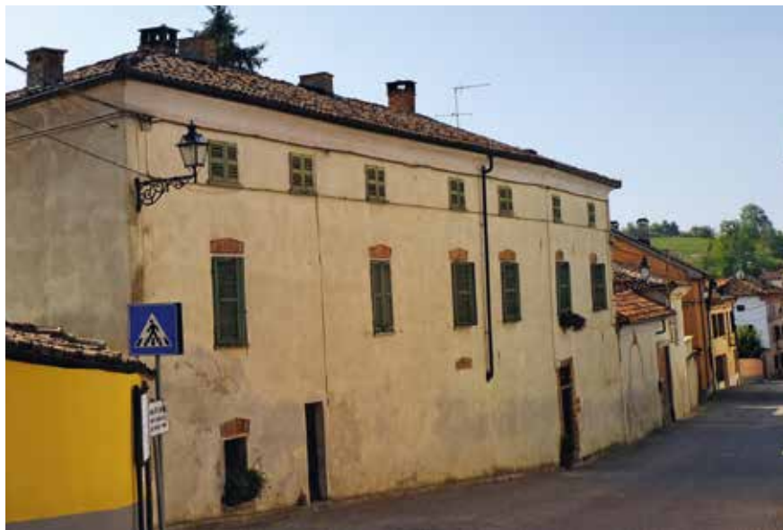
Figura 135: finestre a doppio battente e piccole aperture per sottotetti – Montaldo Scarampi
