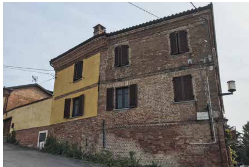
Figura 130: intonacatura di muratura faccia a vista
