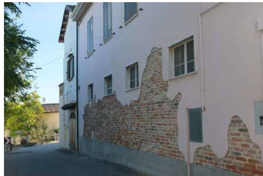
Figura 127: stesa dell'intonaco a macchia
