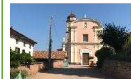
EDIFICI STORICI PARROCCHIALE DI S. PANCRAZIO
