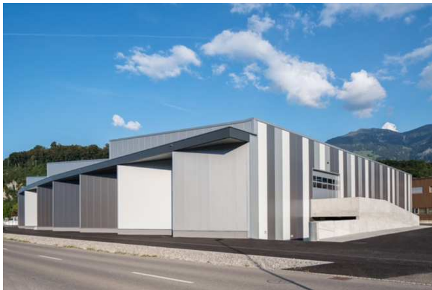
Figura 103: capannone industriale, Kägiswil - Svizzera
