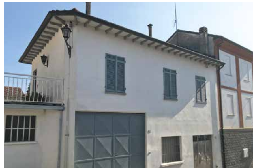
Figura 69: intonacatura dello sporto
