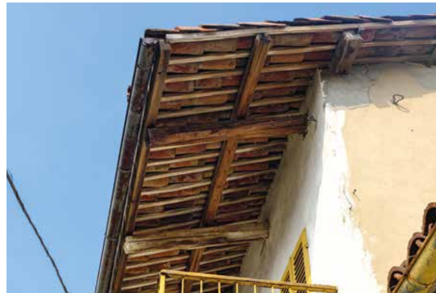
Figura 4: particolare dello sporto del tetto con passafuori incastrati nella muratura che sostengono l’ultimo arcareccio – Vigliano d’Asti
