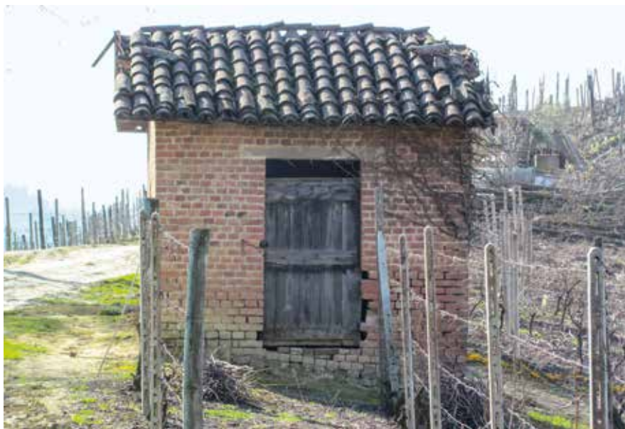
Figura 52: ciabòt in muratura di mattoni e tetto con struttura lignea e coppi (ingresso sul lato di gronda)
