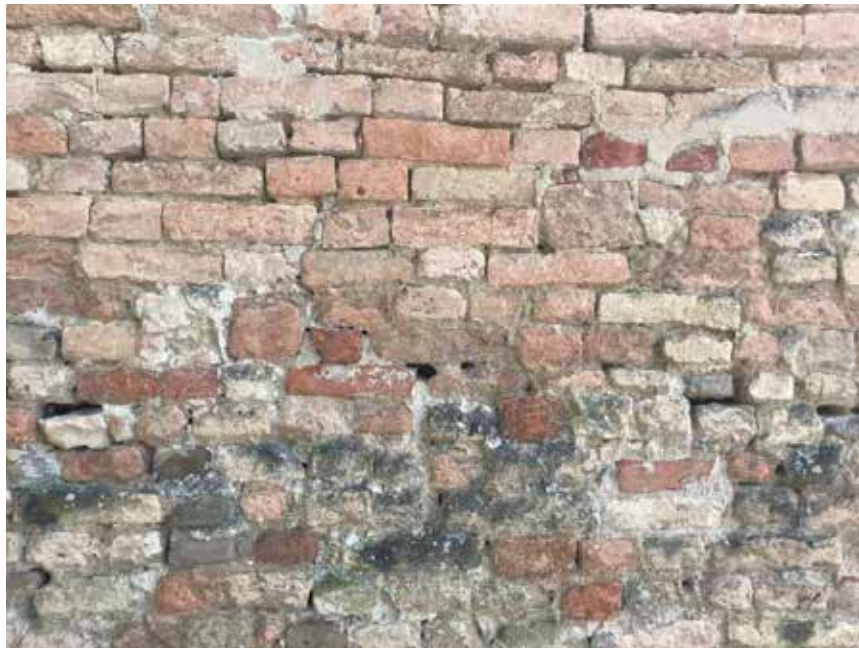
Figura 96: tessitura muraria laterizio – Costigliole
