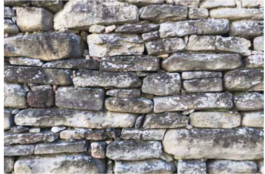
Figura 106: tessitura muraria – Canelli
