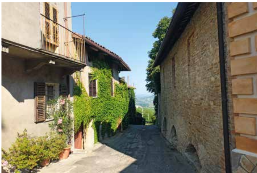
Figura 102: muratura in pietra – Calosso
