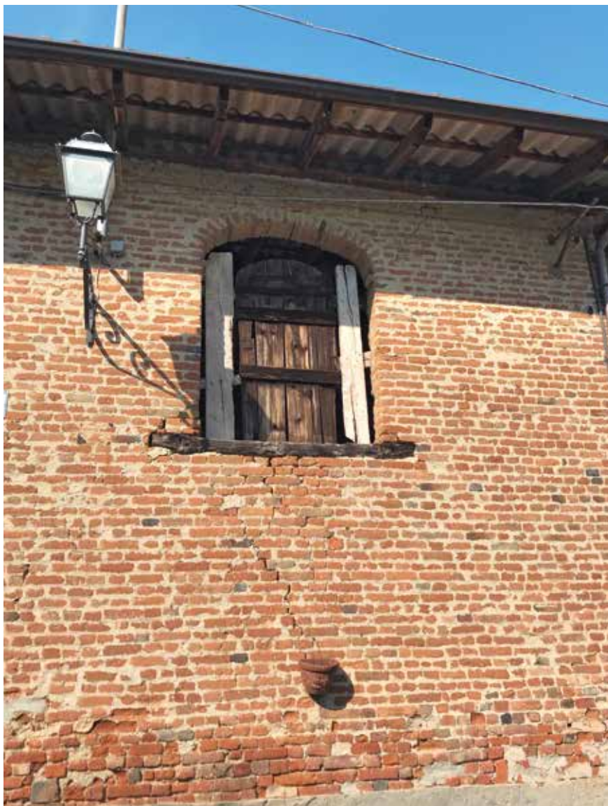
Figura 92: muratura in laterizio corsi regolari - Bruno
