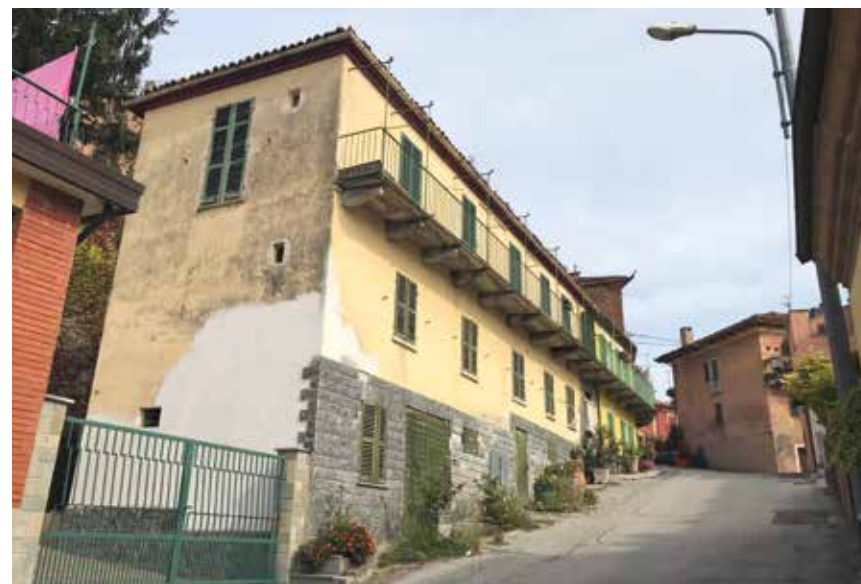
Figura 194: ballatoio all'ultimo piano - Agliano
