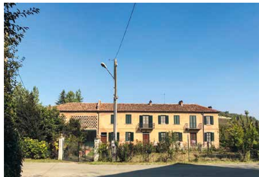
Figura 41: Cascina in linea ristrutturata
