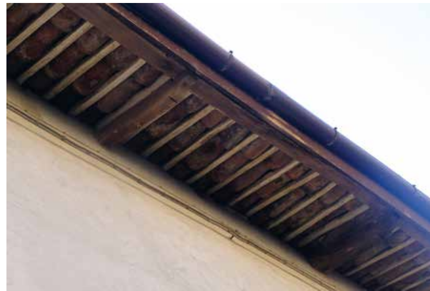
Figura 12: particolare dello sporto del tetto - Agliano Terme
