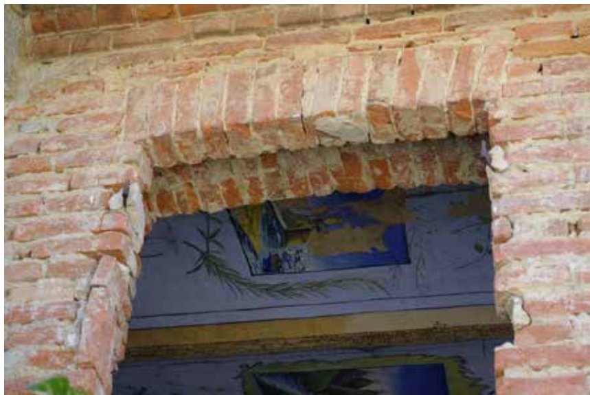
Figura 146: particolare piattabanda finestra - Belveglio
