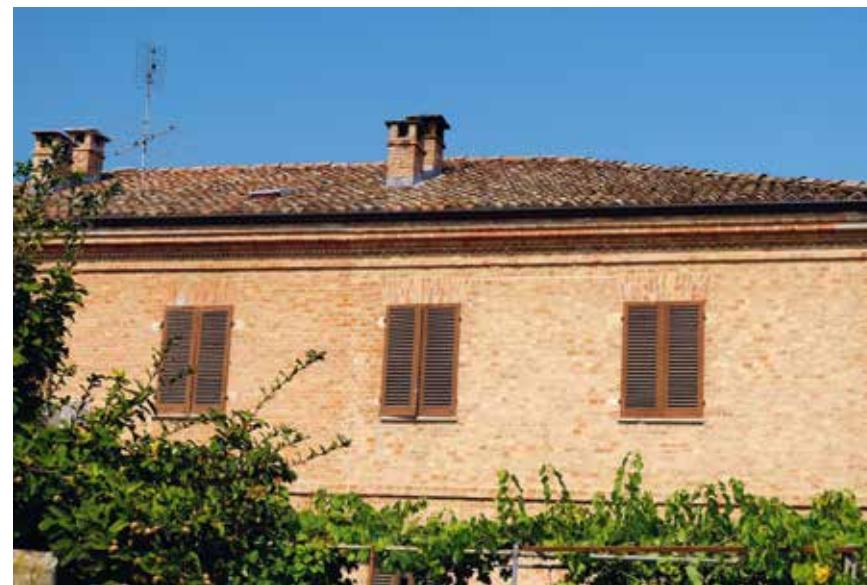
Figura 21: cornice in corsi di mattoni – Belveglio
