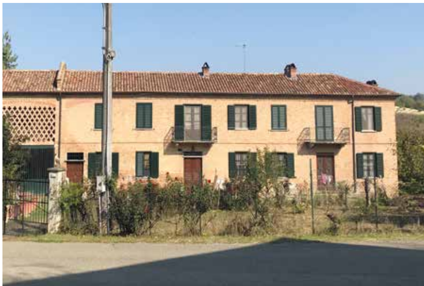
Figura 196: balconi su ingresso principale al primo piano - Montegrosso
