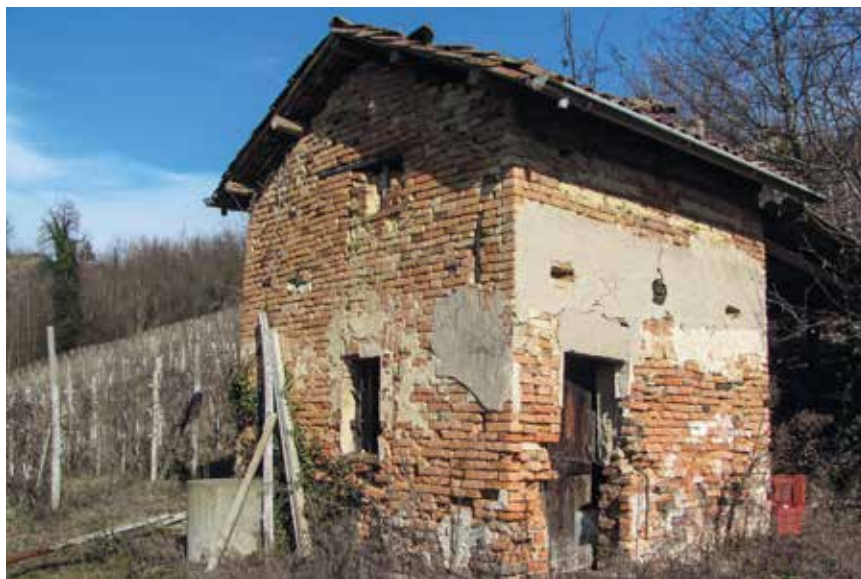
Figura 63: retro di un ciabòt a due piani con muratura in mattoni, architrave ligneo passante, struttura lignea alla lombarda, ingresso sul lato della linea di gronda
