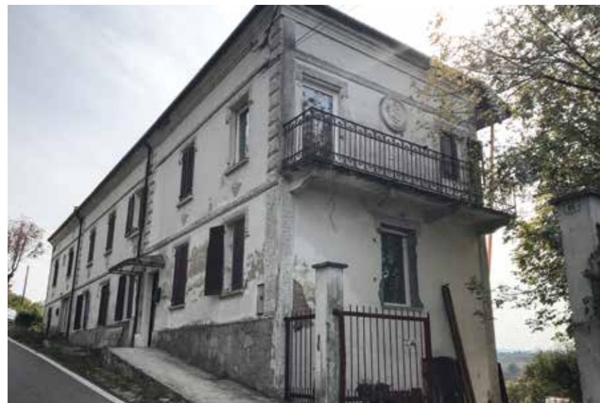
Figura 109: muratura intonacata – Agliano Terme
