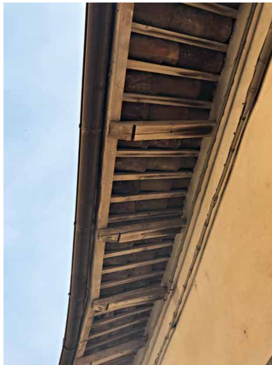
Figura 15: particolare orditura sottofalda - Agliano Terme
