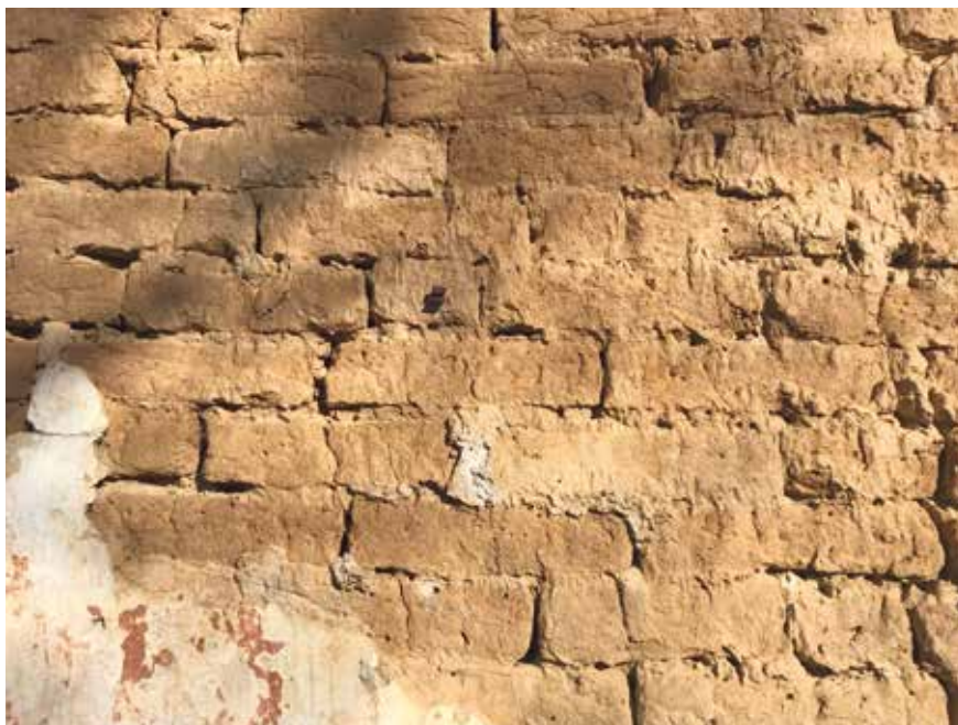
Figura 116: esempio di tessitura muraria in terra cruda
