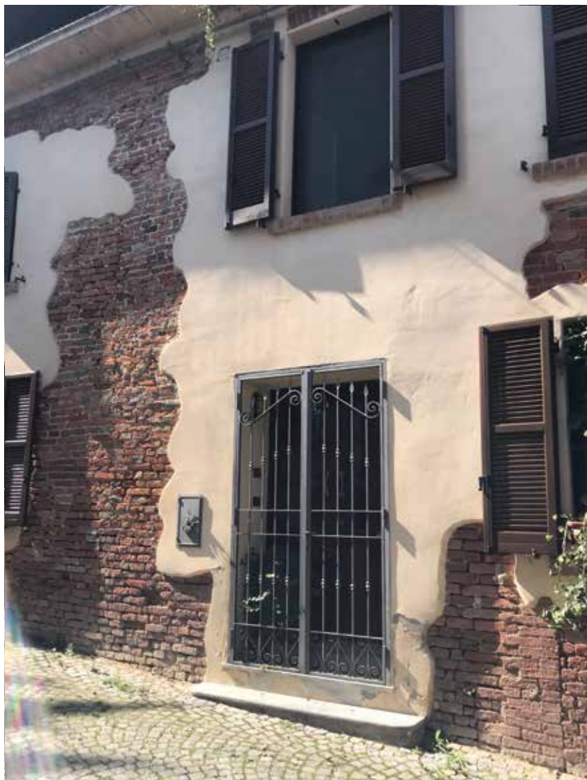
Figura 128: stesa dell'intonaco a macchia
