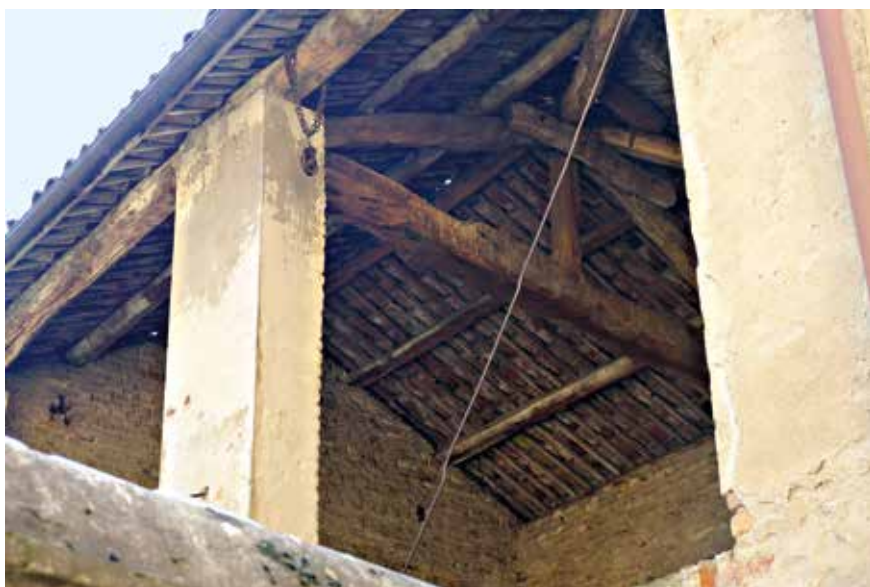
Figura 10: orditura alla lombarda con sistema a capriate - Castelnuovo Belbo
