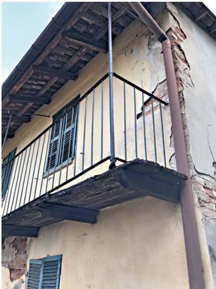
Figura 203: particolare di ballatoio ligneo – Isola d’Asti
