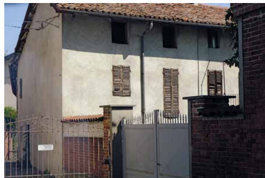
Figura 138: finestre a doppio battente e piccole aperture per sottotetti – Azzano d'Asti
