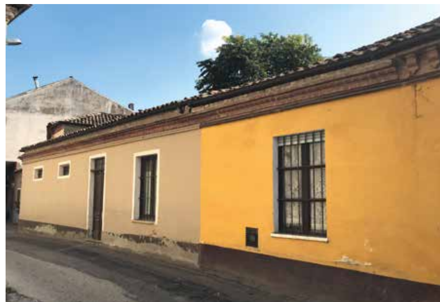
Figura 29: cornicioni aggettanti in mattoni - Coazzolo
