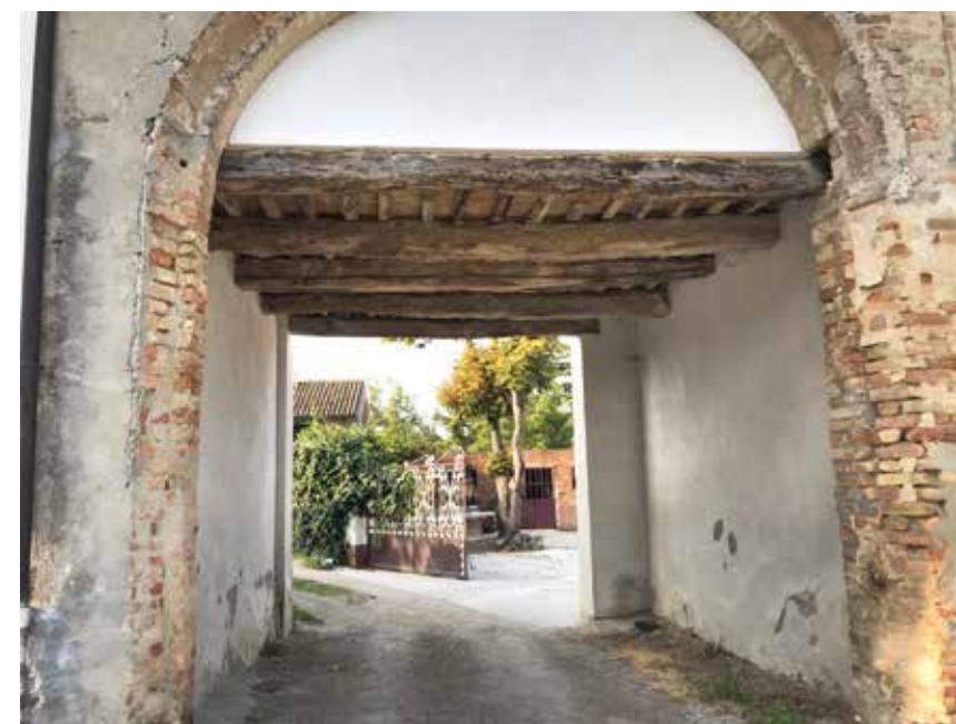
Figura 220: passaggio coperto con solaio con travi e travetti in legno - Costigliole
