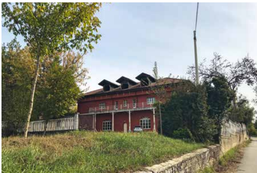
Figura 71: scorretto inserimento degli abbaini (proporzioni e allineamento in facciata)
