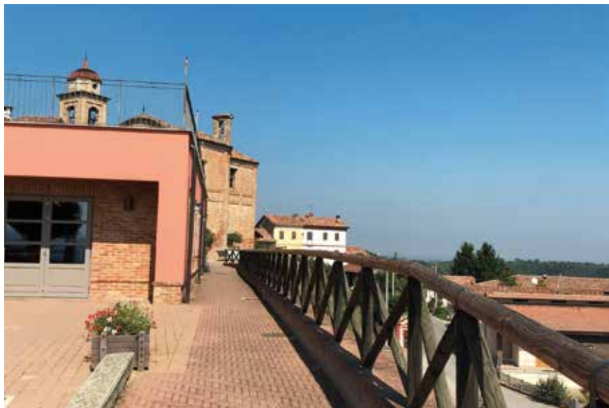
Figura 55: Passaggio sopra muro
