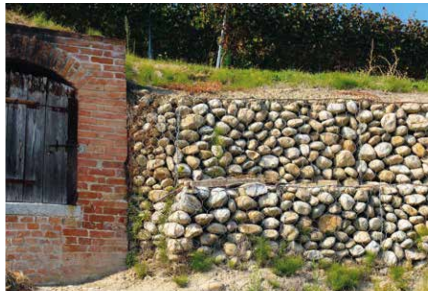
Figura 45: gabbionate in acciaio e pietrame
