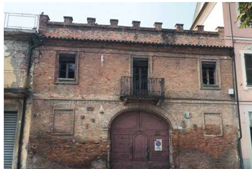
Figura 94: muratura in laterizio con archi, piattabande, fasce decorative
