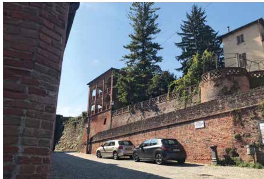
Figura 79: Spazio per la sosta sotto muraglione
