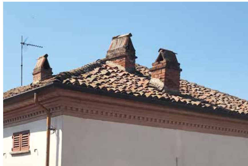
Figura 49: comignolo con copertura a capanna in elementi di laterizio e foro di uscita dei fumi triangolare – Vaglio Serra
