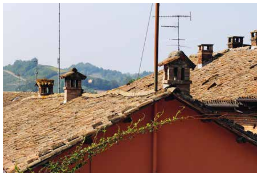
Figura 42: comignolo con copertura a capanna in coppi – Belveglio
