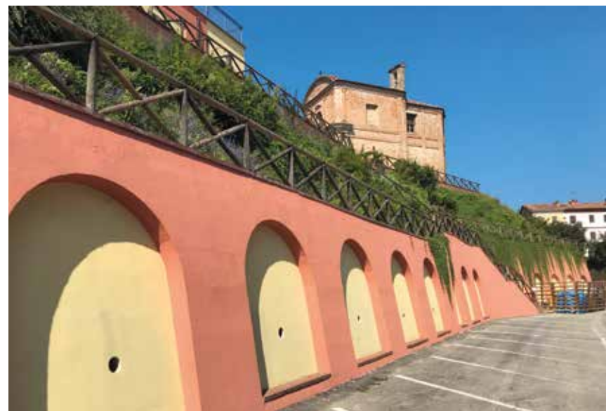
Figura 53: Muraglione con interventi di ingegneria naturalistica
