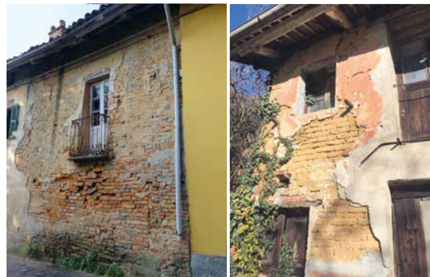
Figura 119: muratura in laterizio e mattoni crudi – Vinchio
