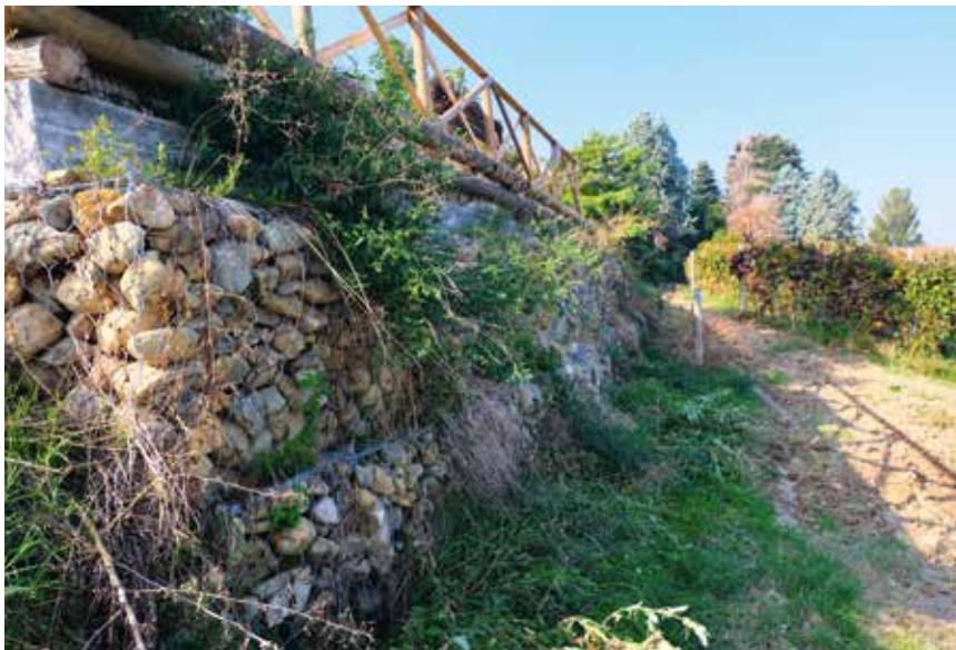
Figura 49: sistemazione mista gabbione/palificata (soluzione da evitare)
