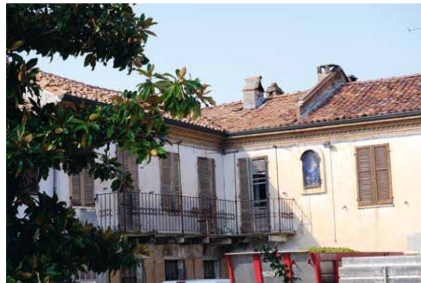
Figura 20: cornice con elementi in cotto sagomati - Coazzolo
