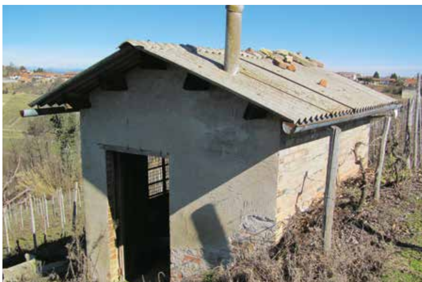
Figura 72: ciabòt intonacato, con copertura in lamiera (intervento non compatibile)
