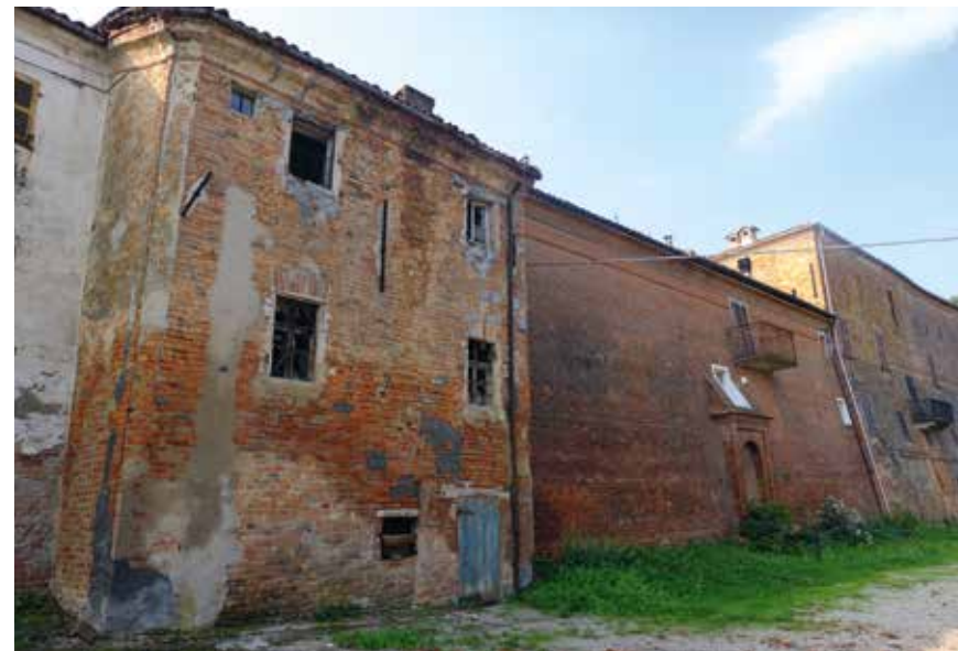
Figura 82: muratura in laterizio - Vigliano
