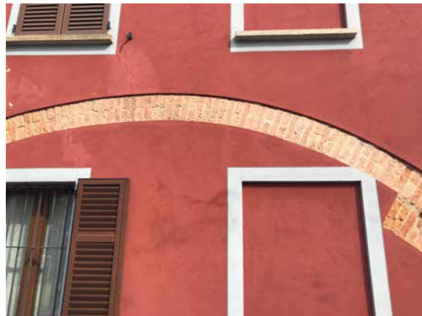
Figura 129: porzioni di muratura lasciate a vista
