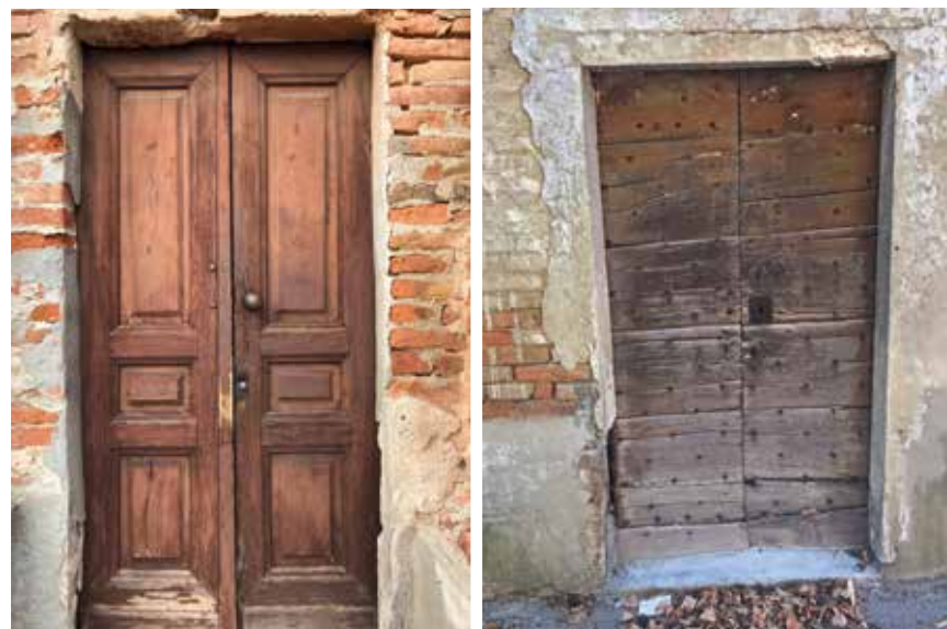
Figura 158: portoncino a due battenti con riquadri - Mongardino
