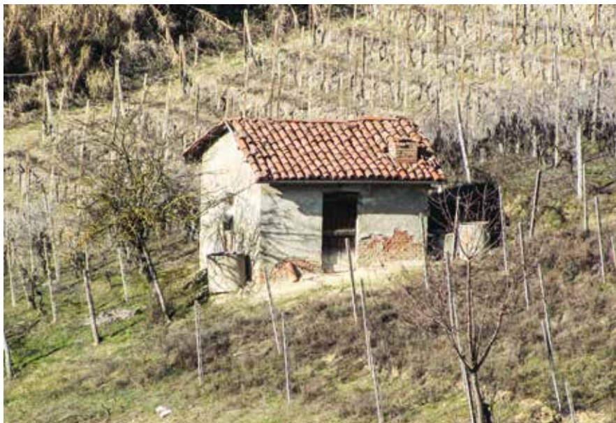
Figura 55: ciabòt con muratura in mattoni intonacata e camino; ingresso posto in corrispondenza della linea di gronda
