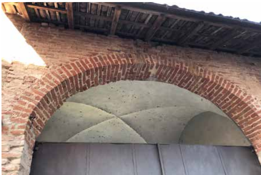
Figura 13: particolare dello sporto del tetto con prolungamento degli arcarecci - Bruno
