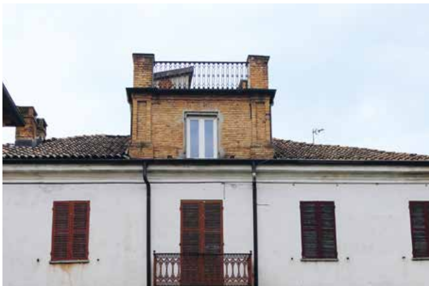
Figura 78: scorretto inserimento del serramento dell'abbaino
