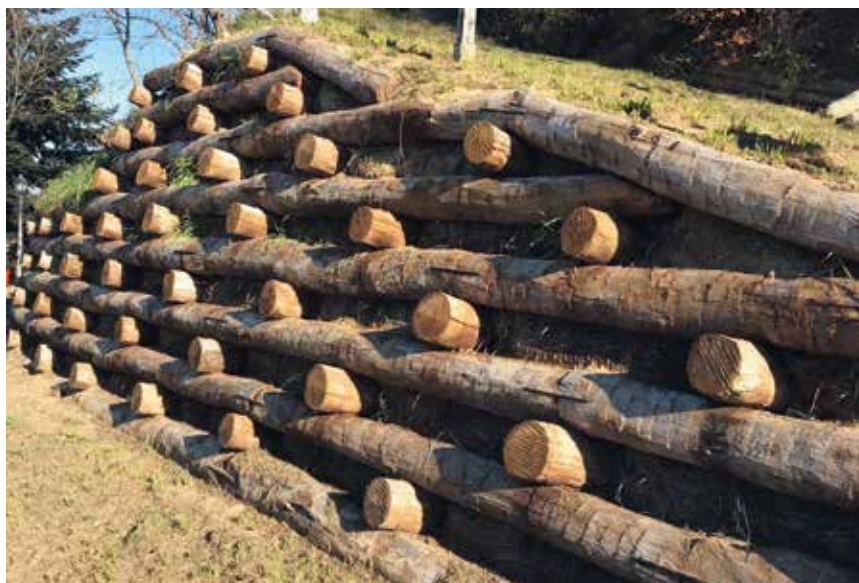
Figura 124: Opere di ingegneria naturalistica a consolidamento del rilievo della Rocca del Castello
